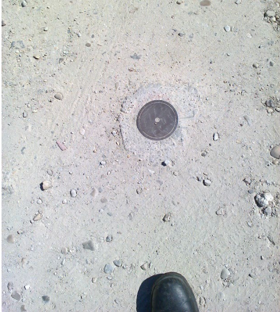
Modelo de tapas de piezómetros instalados
