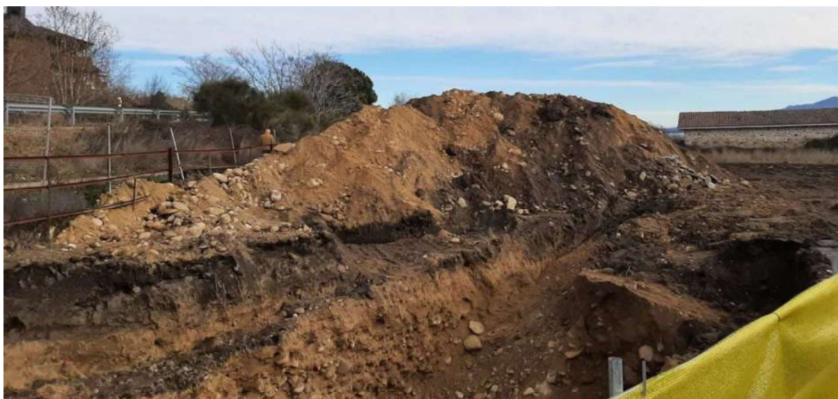
Foto 2. Excavaciones en el Pozo de Ataque. Véase la presencia de bolo graníticos de gran tamaño.
