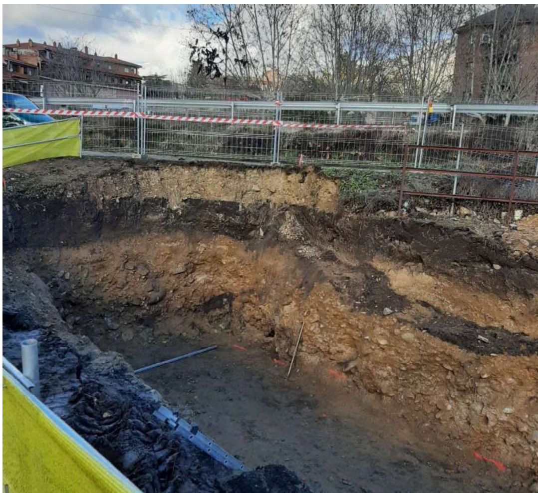
Foto 1. Excavación realizada en el Pozo de Ataque. Obsérvese en el corte frontal la presencia de rellenos y suelos vegetales, así como arenas medias a gruesas y arenas arcillo limosas, con gravillas, gravas y bolos graníticos heterométricos de tamaños muy variables.
