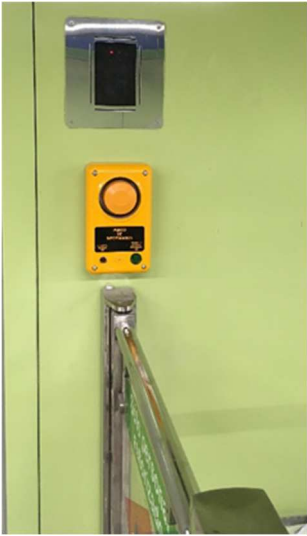
Figura 112: Situación final (ejemplo de instalación de interfono / teleportón)
