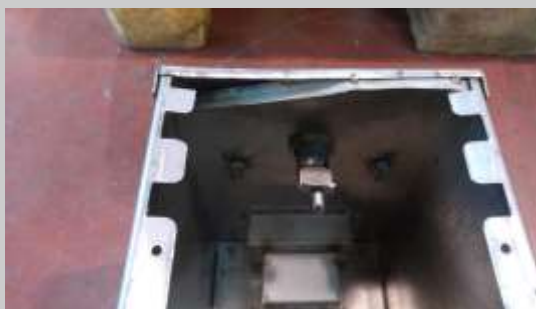
Zona del cierre de la tapa deformada.
