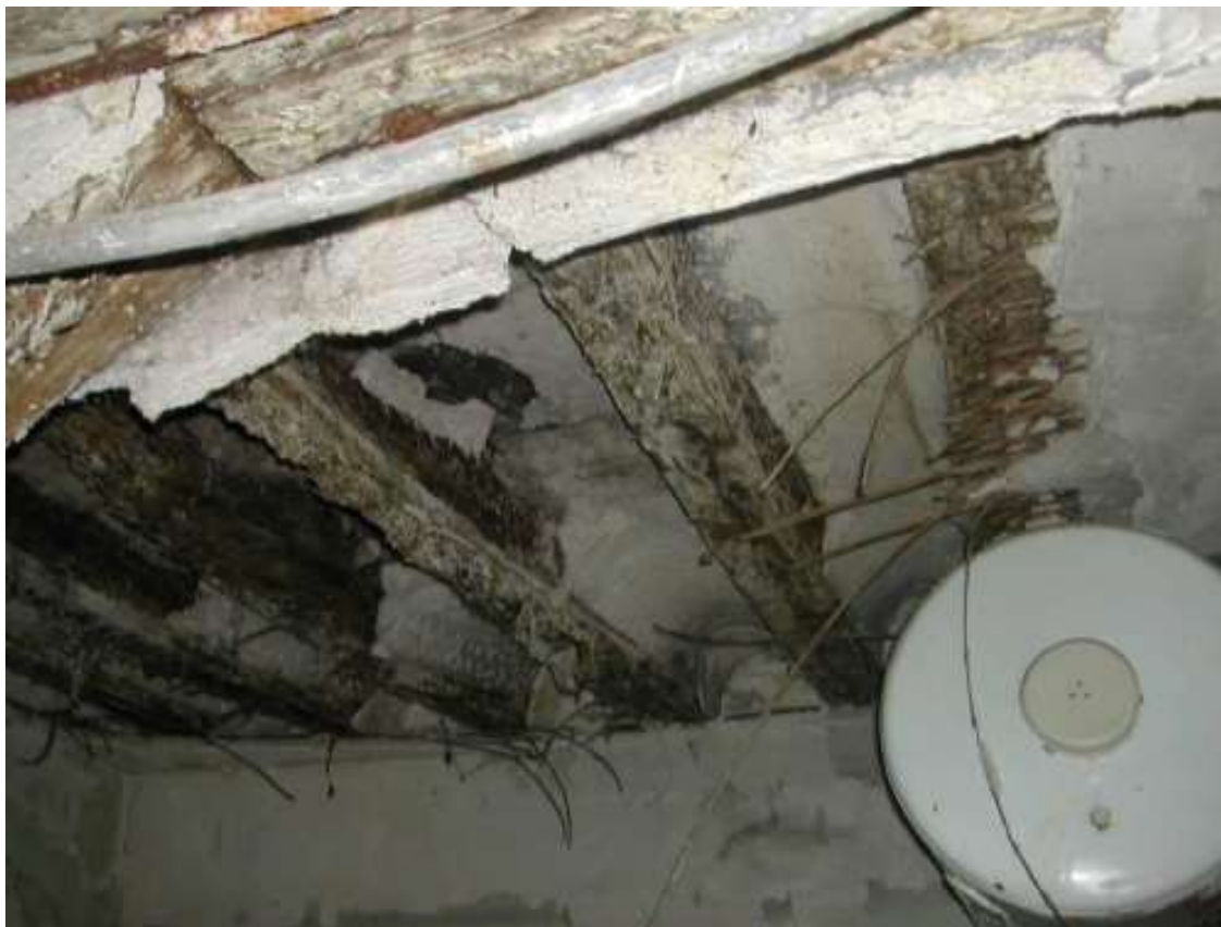
Detalle inferior forjado
