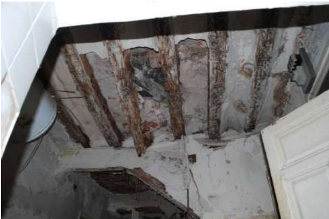
Detalle cara inferior forjado
