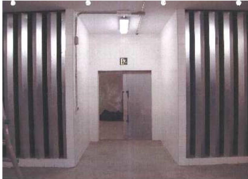
Figura 9. Silenciadores de baffles paralelos.
