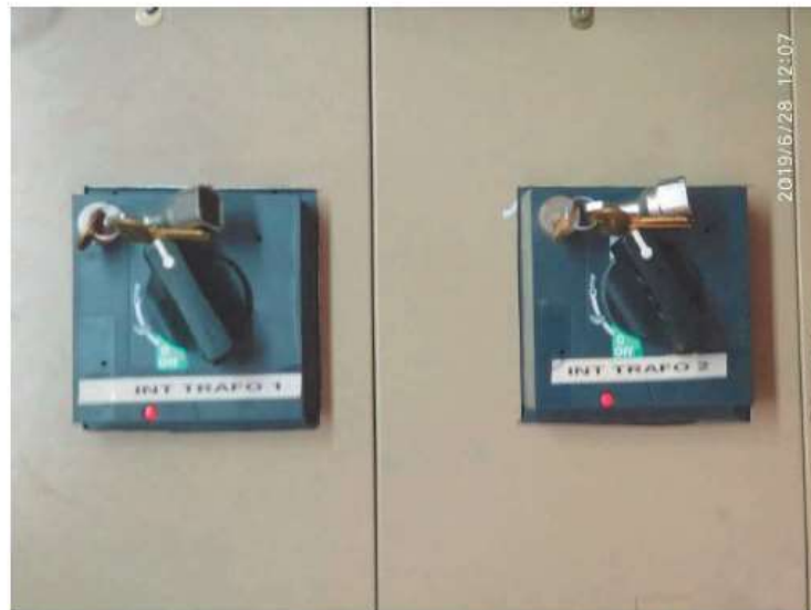
SALIDAS DE 630 A DE LOS TRAFOS. 1 DE LAS SALIDAS PARA SUMINISTRO A IVE's
