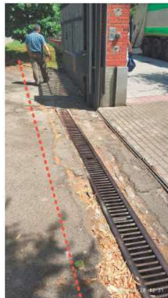
TRAZADO DE CANALIZACION ENTERRADA EN ASFALTO JARDIN CANAL YII
