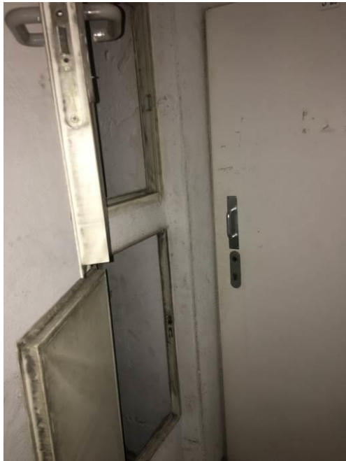
Ampliación de hueco en patinillos para ampliar tamaño de puertas de registro. Vista de las trampillas del patinillo 1, en planta sótano.
