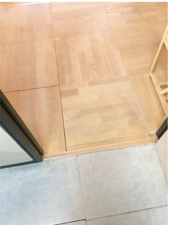
FOTO 03 SUELOS TÉCNICOS CON DIFERENTES ACABADOS: PVC Y MADERA
