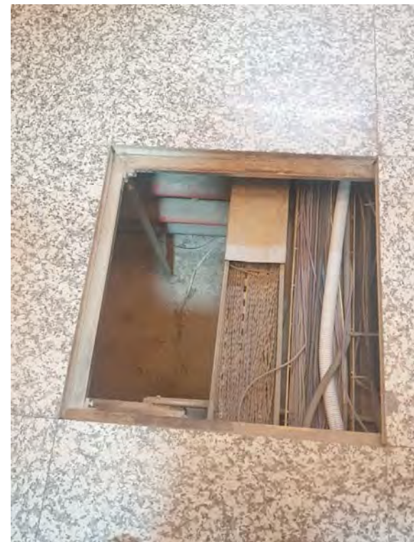
FOTO 11 GALERÍA BAJO EL SUELO TÉCNICO DE LOS DISTRIBUIDORES
