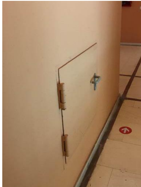
Ampliación de hueco en patinillos para ampliar tamaño de puertas de registro. Vista de la trampilla del patinillo 1 en la planta primera.
