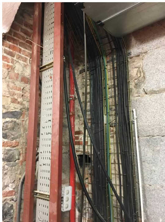
Canalizaciones y cableados vistos en el arranque del Patinillo 3 (zona Cuarto de basura).
