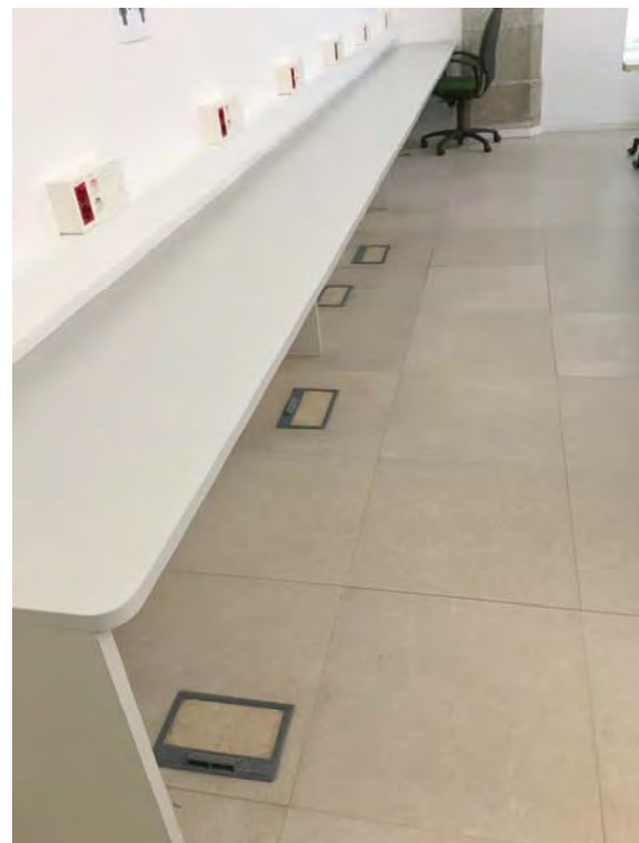
FOTO 11 CAJAS DE VOZ Y DATOS EN SUELO TÉCNICO Y PUSTOS DE LA ZONA DE MEDIOS DE COMUNICACIÓN
