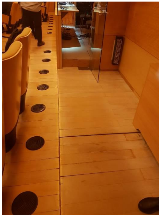
Incorporación de nuevas canalizaciones bajo la tarima de madera existente.
