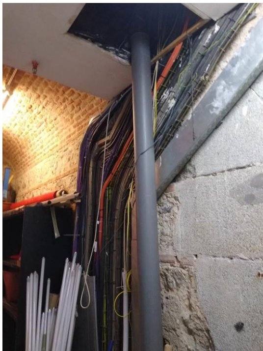
Canalizaciones y cableados vistos en el arranque del Patinillo 2 (zona Vestuario de mantenimiento).
