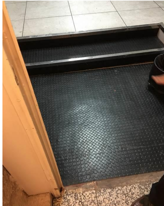
Ampliación de hueco en solera de planta sótano para ampliar el paso de nuevas canalizaciones y para nueva trampilla de registro. Acceso a Sala CPD.
