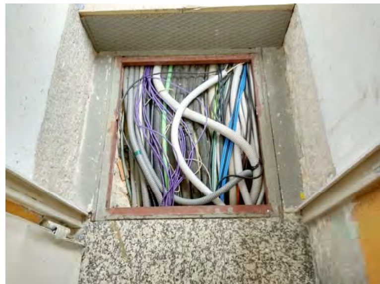
FOTO 12 REGISTRO DE CANALIZACIONES EN SOLADO DE ACCESO A LA SALA 33, IBERCOM
