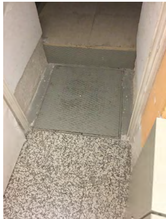
FOTO 13 REGISTRO DE CANALIZACIONES EN SOLADO DE ACCESO A LA SALA 33, IBERCOM
