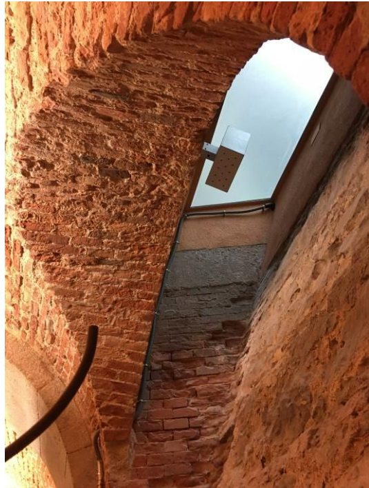
Vista inferior de la tapa de vidrio sobre la tronera, por donde discurrirán las nuevas canalizaciones vistas hasta el nivel de solado.
