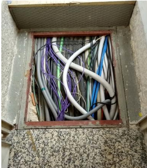
Ampliación de hueco en solera de planta sótano para ampliar el paso de nuevas canalizaciones y para trampilla de mayor tamaño. Acceso a Sala Ibercon.
