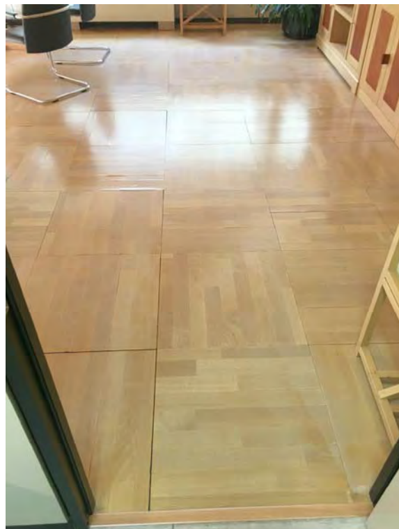
FOTO 04 SUELOS TÉCNICOS ACABADOS EN MADERA EN LAS ÁREAS DEDICADAS A DESPACHOS Y SALAS
