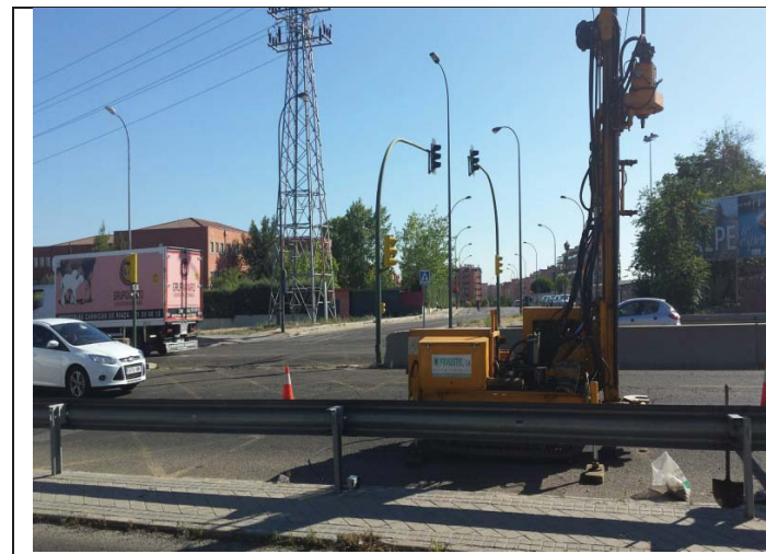
Foto 6.- Zona de emplazamiento del sondeo S-4 realizado también para obtener información sobre el paquete de firme.
