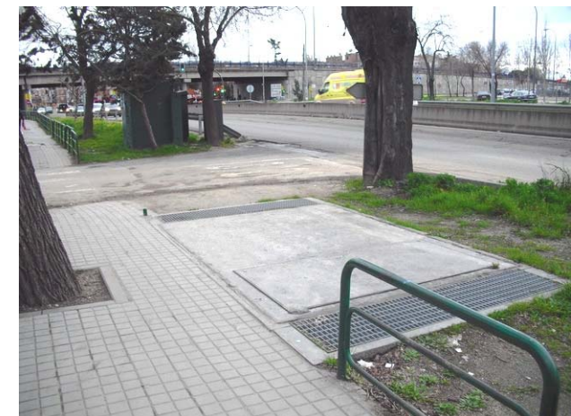
Fotog. 17. Centro de transformación subterráneo junto a acceso al polideportivo Giner de los Ríos
