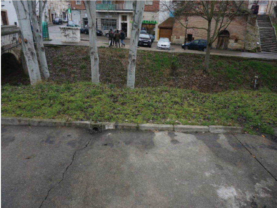
Figura 10. Los drenajes de la calle son acanaladuras sobre el propio suelo
