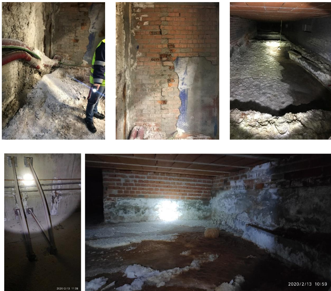
Figura 1: Daños observados: filtraciones, depósitos de sales, perfiles en mal estado
