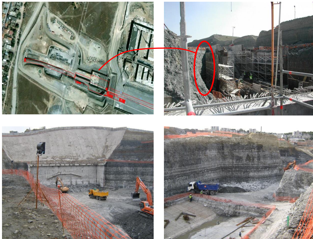
Figura nº 4. Planta y fotos de la excavación durante la fase de obra
