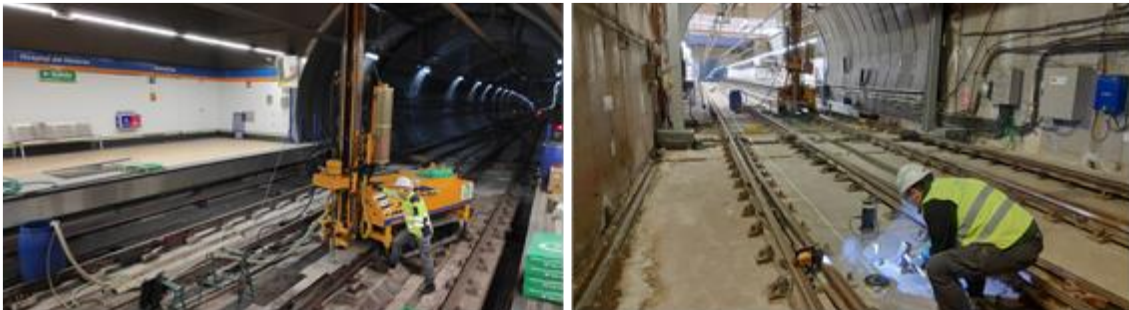
Figura nº 7. Ejecución de sondeos y ensayos geofísicos realizados en el interior de la estación
