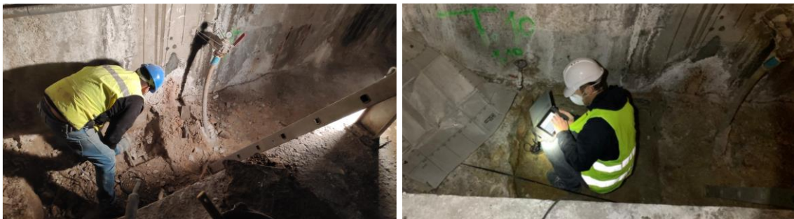
Figura nº 8. Ejecución de calicatas y perfiles de georradar con apoyo de Profometer Proceq PM-650 Hilti X SCAN PS 1000
