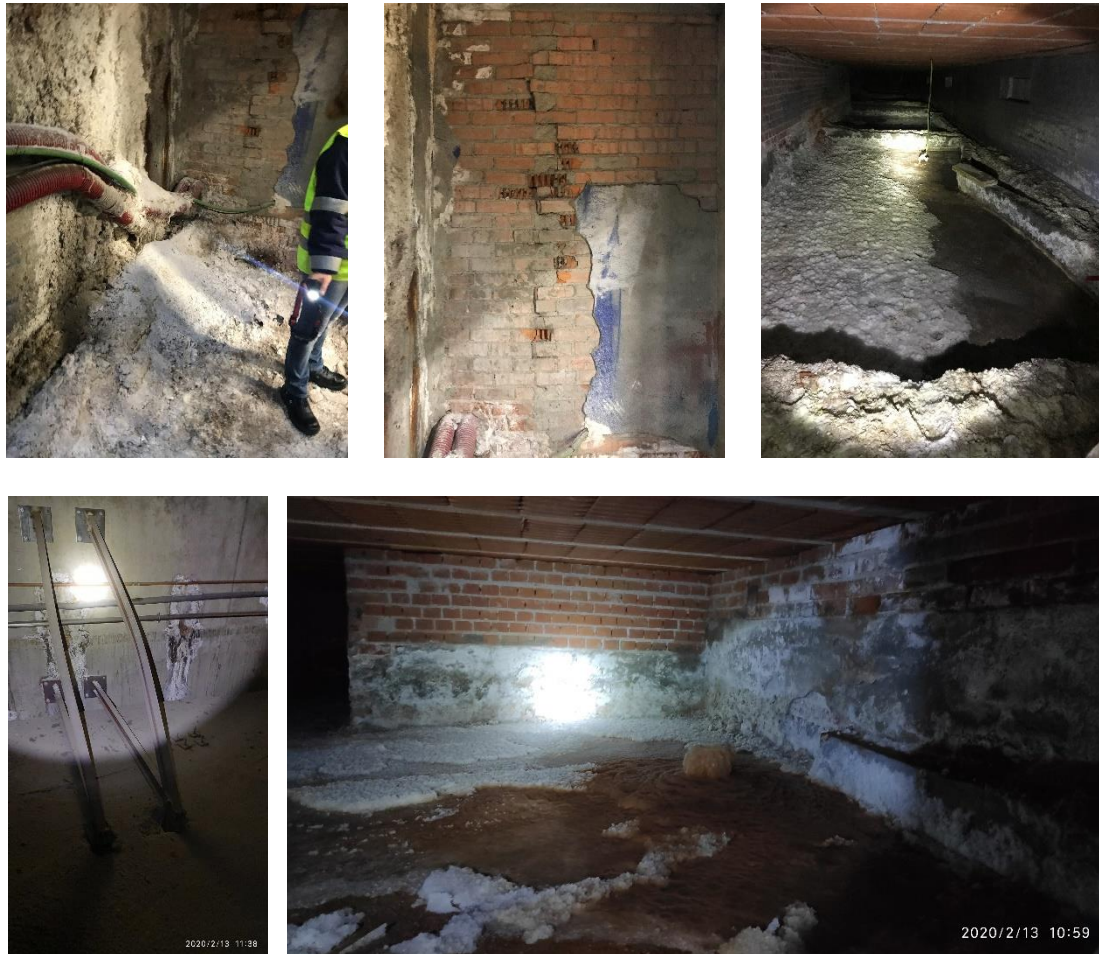
Figura 3: Daños observados: filtraciones, depósitos de sales, perfiles en mal estado
