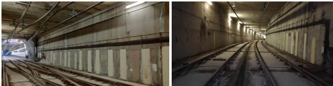
Figura 4: Membranas impermeabilizantes instaladas en el lado sur
