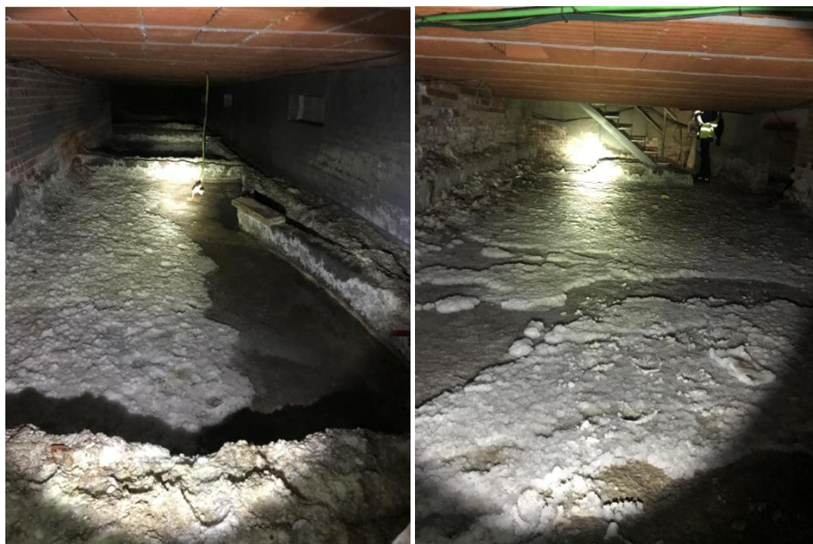
Figura 5: Depósitos de sales bajo andén (lado sur)
