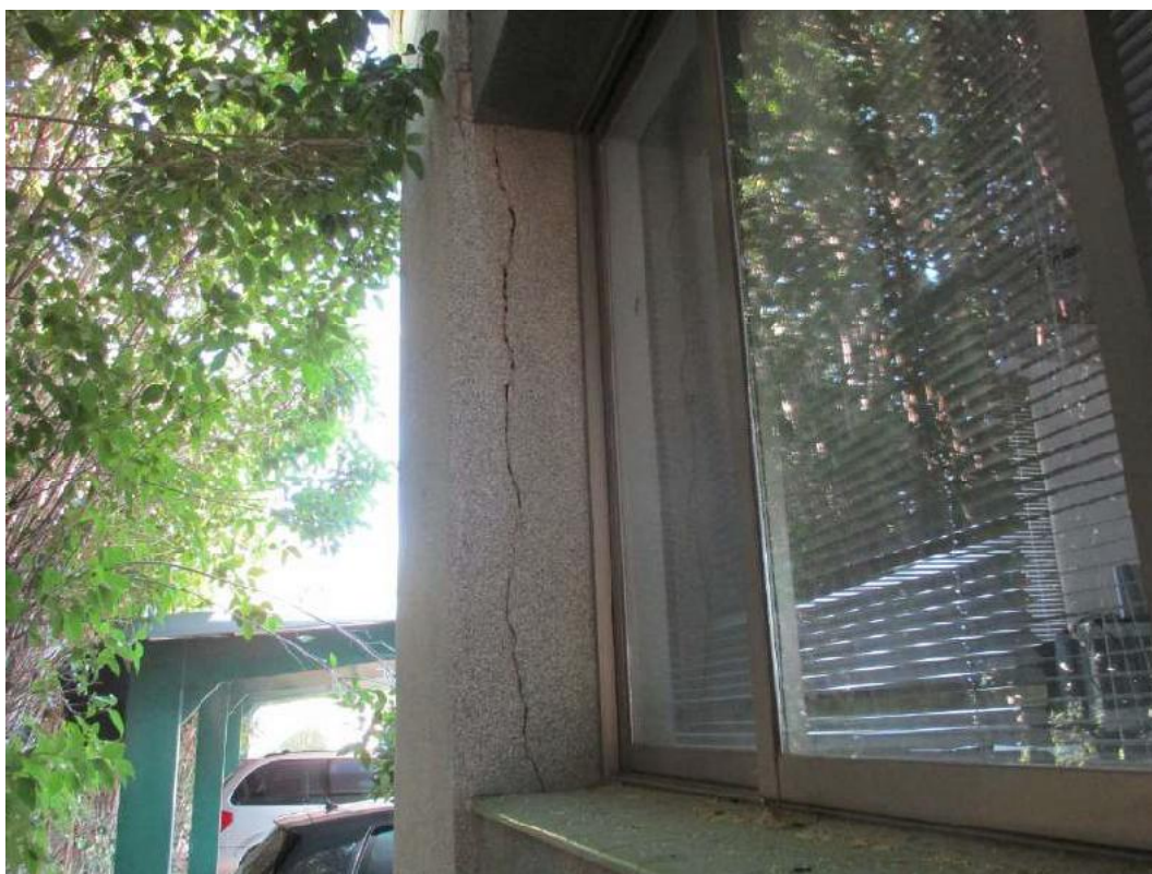
Fotografía n° 7: fisura vertical en la jamba de una ventana.
