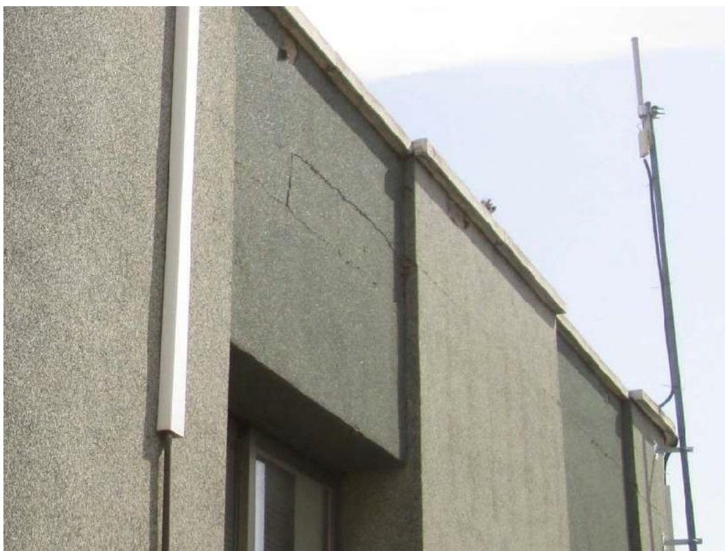
Fotografía n° 3: fisuras horizontales (y alguna vertical) en la parte superior del cerramiento.
