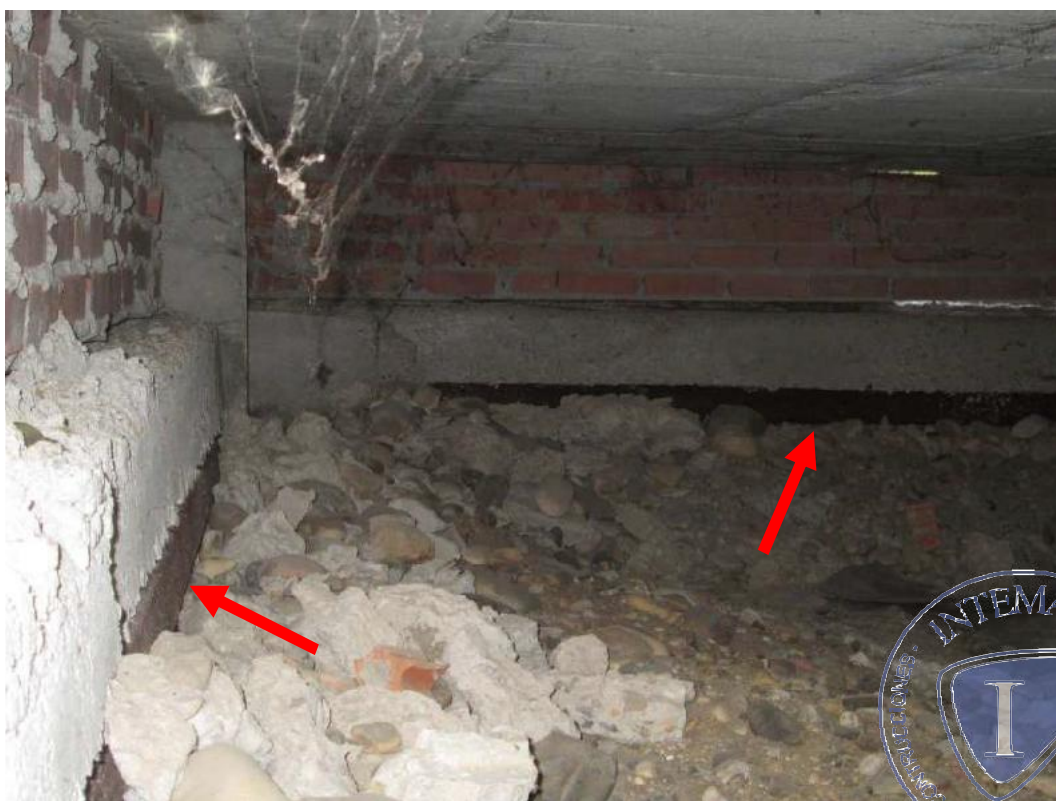
Fotografía nº 22: cámara de aire bajo el forjado, perfiles metálicos de apoyo de la solera de hormigón de la acera.
