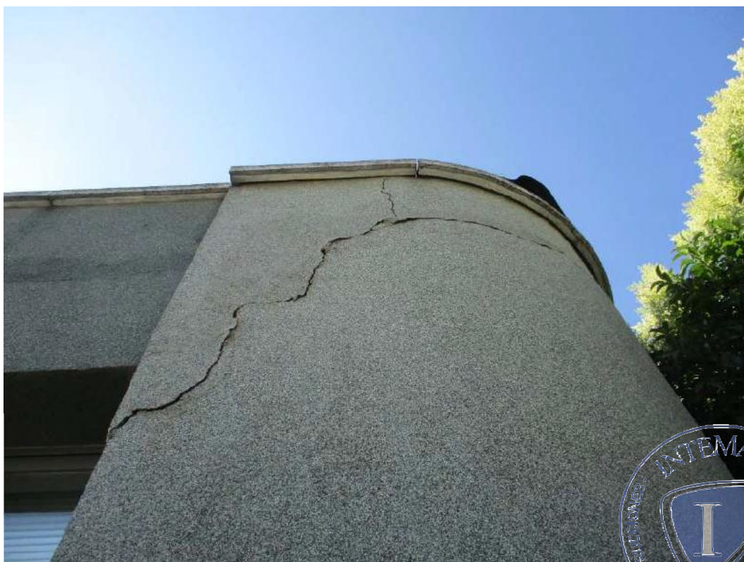
Fotografía nº 12: fisura inclinada y ascendente.
