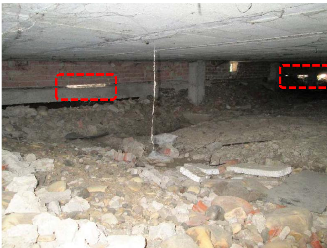
Fotografía nº 21: cámara de aire bajo el forjado, fisuras pasantes en el encuentro con la hoja exterior del cerramiento.
