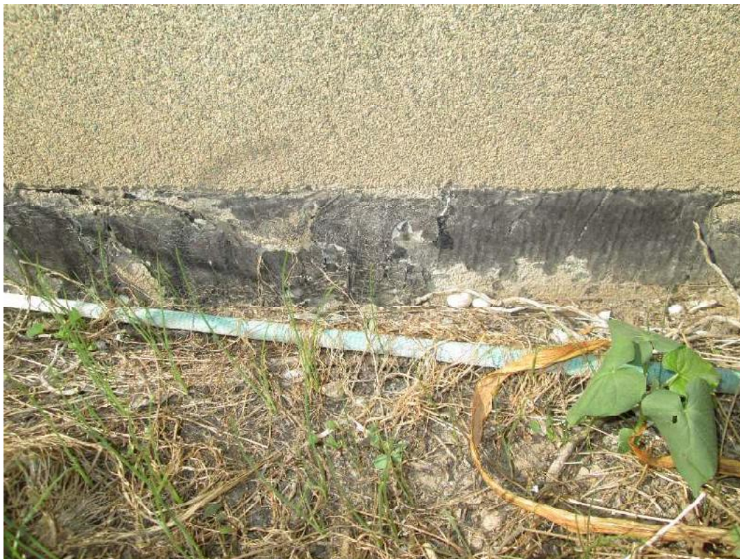
Fotografía n° 23: sistema de impermeabilización del interior de las jardineras, parcialmente al descubierto, fisurado y despegado.
