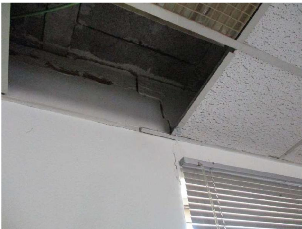
Fotografía n° 17: fisura inclinada y horizontal en el encuentro con el forjado superior, hoja interior del cerramiento.
