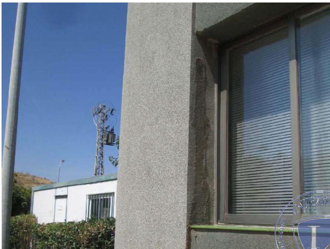
Fotografía n° 8: fisura vertical en la jamba de una ventana, reparada.
