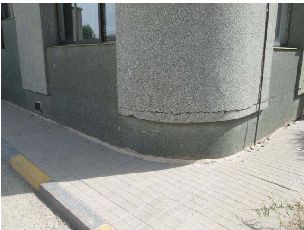
Fotografía n° 1: fisuras horizontales en la parte inferior del cerramiento de fachada.
