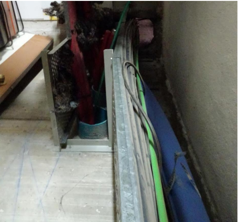
Imagen 4-5 Entrada de cables de MT del centro de transformación AMPSO 1
