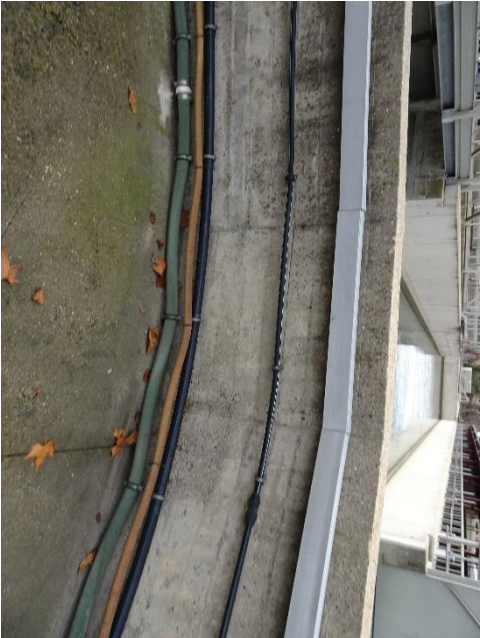
Imagen 2-8 Canalización de cables sobre bandejas en la pared del edificio de decantación
