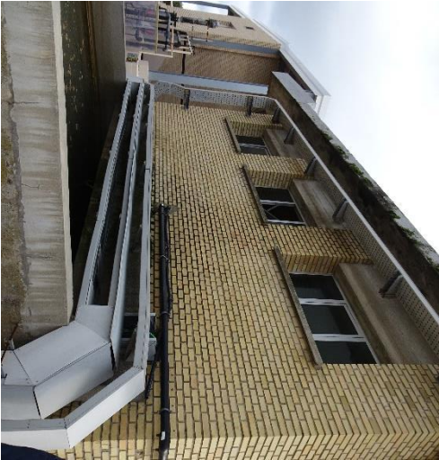
Imagen 2-8 Canalización de cables sobre bandejas en la pared del edificio de decantación
