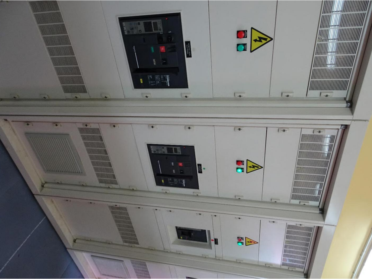
Imagen 5-2 Cuadro general de baja tensión del centro de transformación AMPSO 2
