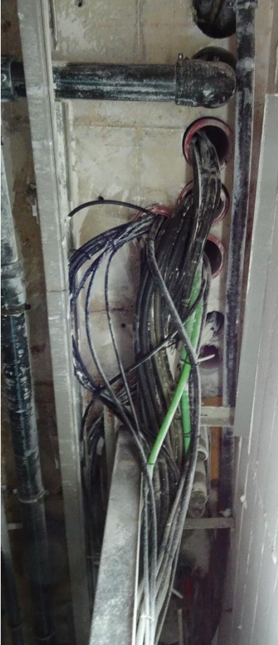
Imagen 2-6 Cables enterrados bajo tubo en la galería
