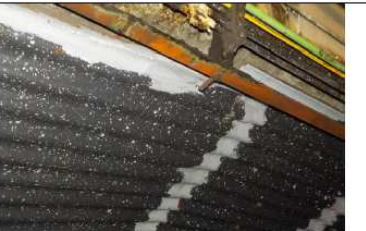
Detalle de encapsulado de defectos y deterioros con dos capas de membrana líquida de poliuretano líquido en dos colores (sin imprimación)
