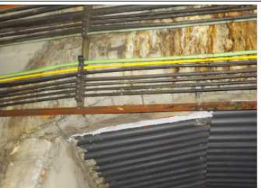
Detalle de encapsulado de defectos y deterioros con dos capas de membrana líquida de poliuretano líquido en dos colores (sin imprimación)
