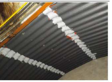
Cubierta de protección en mechina, aproximadamente 4,00 m² (fibrocemento)
