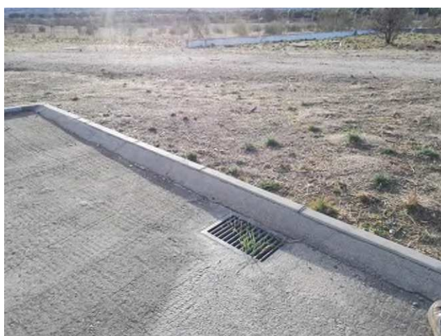
Imbornal recogida de aguas pluviales en la plataforma existente.
