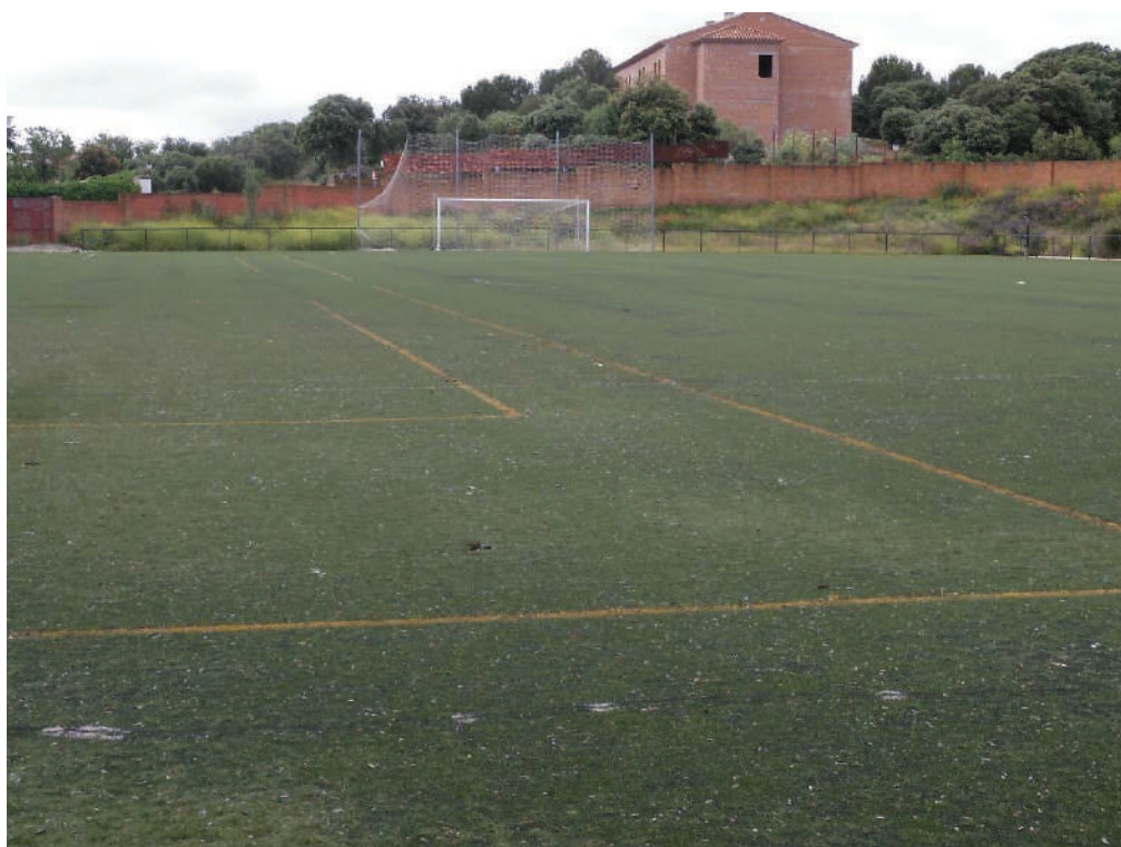
Otra imagen del estado del césped artificial existente en el momento de redactar el proyecto
