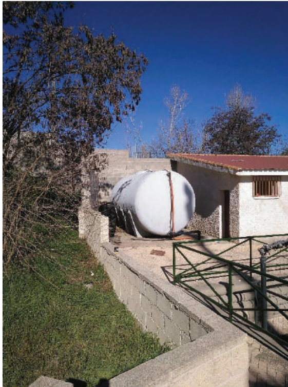
Vista del depósito para riego del césped artificial
