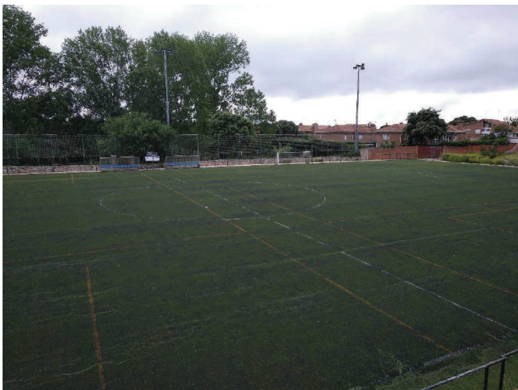
Vista del estado de deterioro generalizado del césped artificial.
