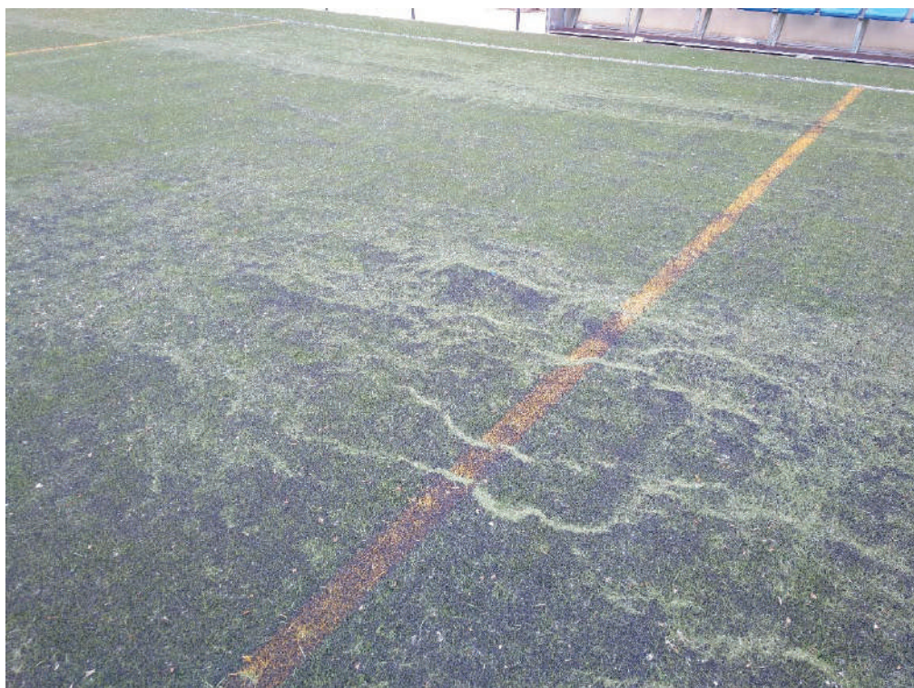
Detalle del deterioro del césped artificial
