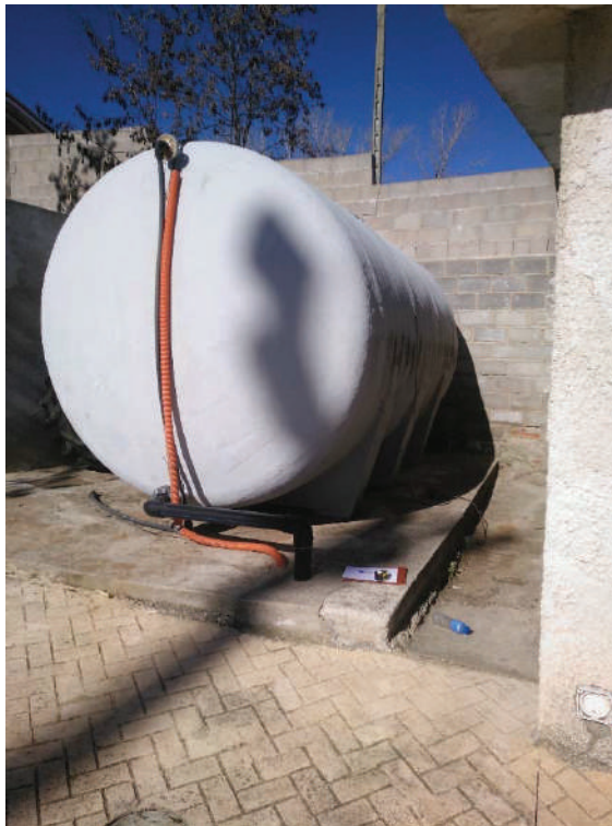
Detalle del depósito para riego del césped artificial
