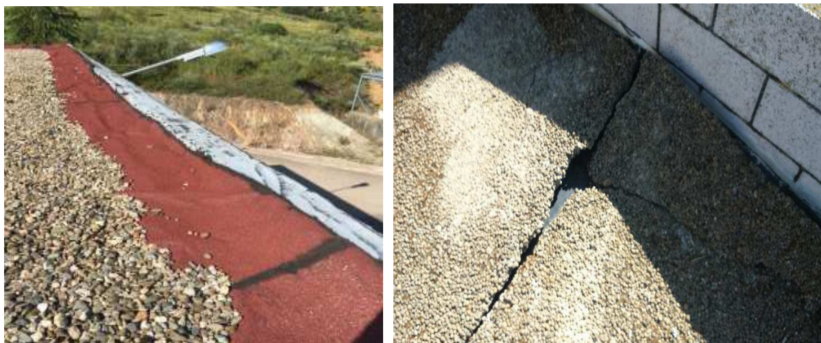
Imagen 7: Detalle rotura láminas impermeabilizantes
