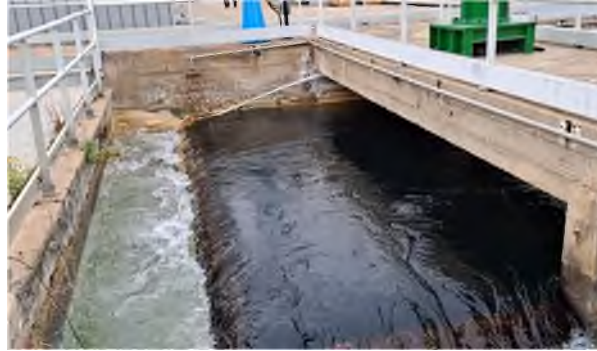
Imagen 9: Punto de dosificación cámara de mezcla rápida
