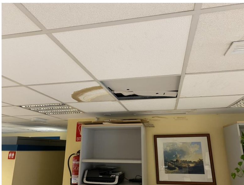
Fotografía desperfectos en falso techo por filtraciones
