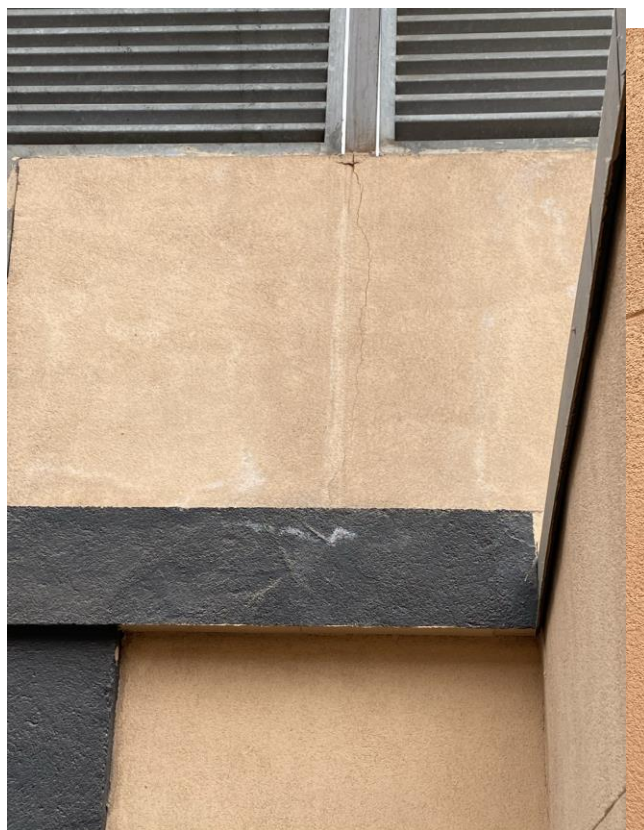
Fotografías fisuras en enfoscado en patios medianeros noroeste
