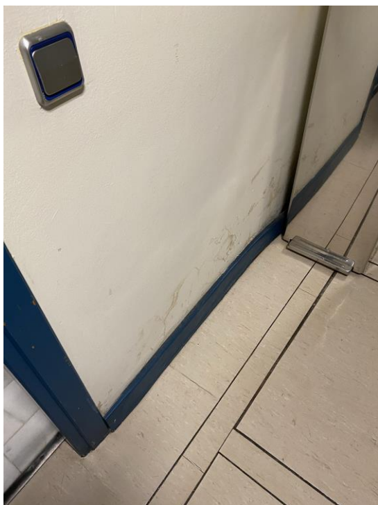
Fotografías deficiencias por filtraciones por capilaridad
