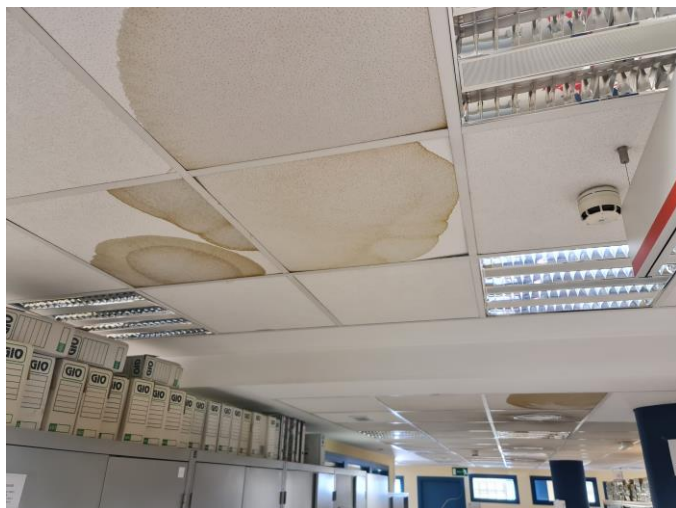
Fotografías daños apreciables por filtraciones
