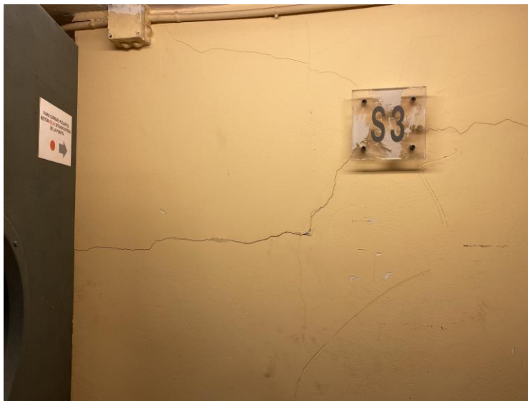
Fotografía fisuras diagonales en paramentos
