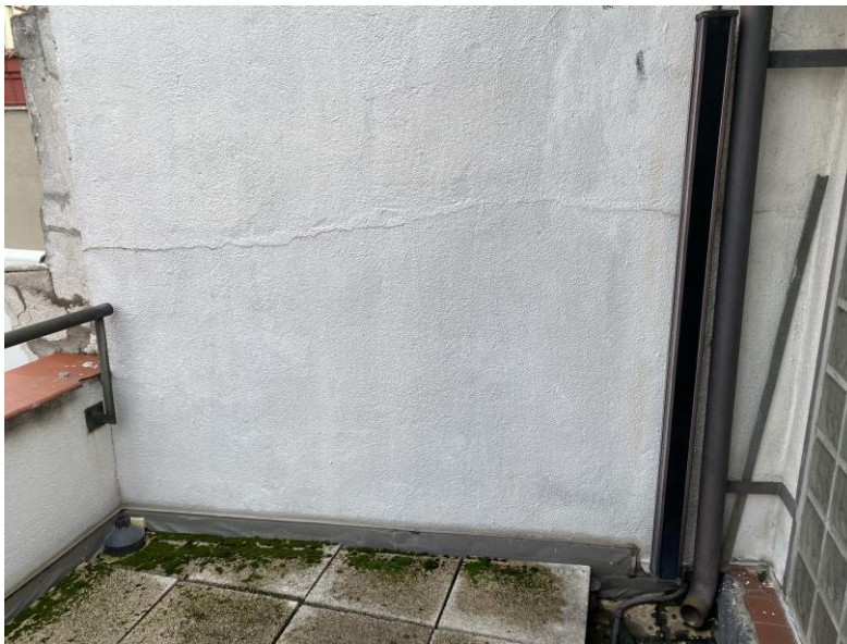
Fotografía muro medianero en terraza norte. Fisura.
