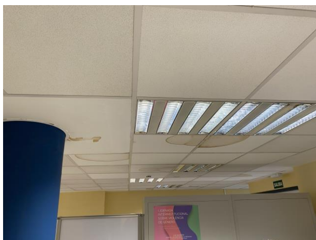
Fotografía desperfectos en falso techo por filtraciones
