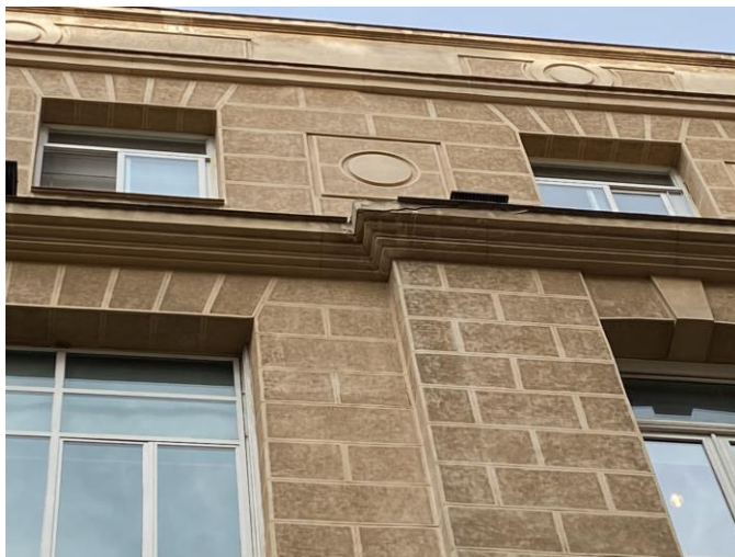
Fotografía voladizos en fachada sur con desperfectos y desprendimientos, así como albardillas rotas y/o desprendidas
