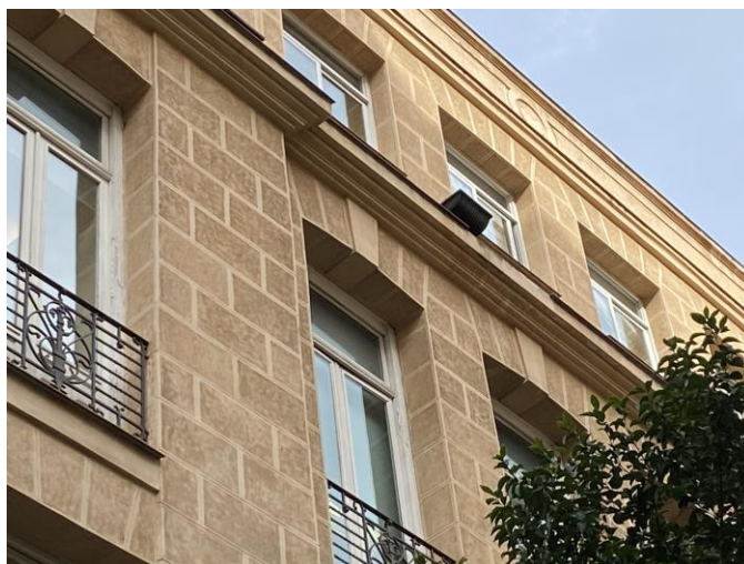
Fotografía voladizos en fachada sur con desperfectos y desprendimientos, así como albardillas rotas y/o desprendidas
