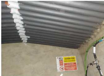
Señalización de presencia de MCA en le mechina
