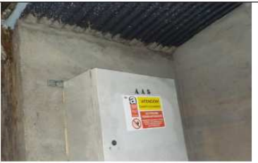
Detalle de señalización de elementos con MCA.
