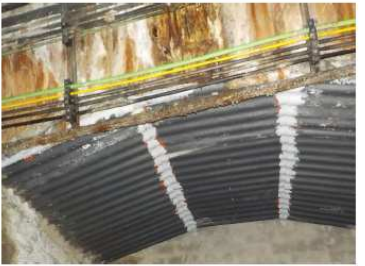
Detalle de encapsulado de defectos y deterioros con dos capas de membrana líquida de poliuretano líquido en dos colores (sin imprimación)
