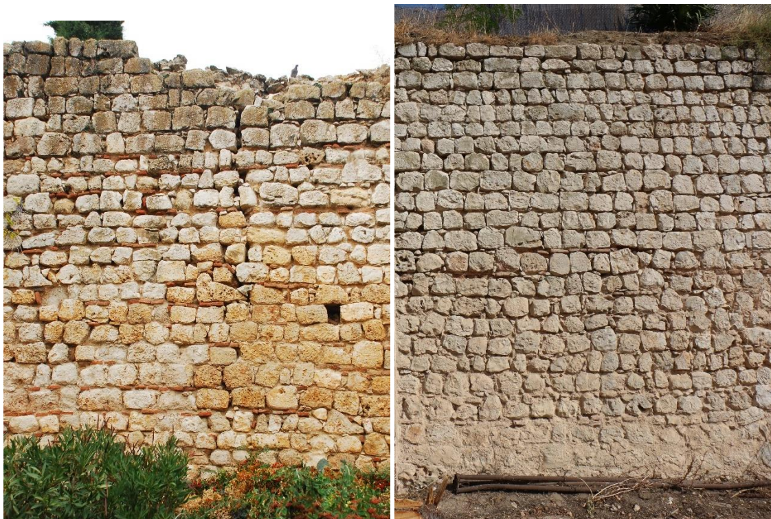
La primera imagen pertenece al lienzo oriental ligado al torreón poligonal, en la segunda imagen se ve el lienzo del tramo 4 -sobre el que se actúa- que acomete a la Torre Hueca o Albarrana., ambas realizadas en sillarejo.
