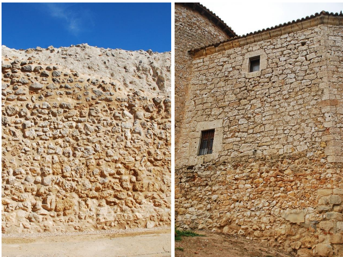
A la izquierda, muro de mampostería del tramo 1 tras su intervención en 2019, con la diferenciación de morteros del núcleo y del paramento exterior; a la derecha sacristía sobre muro de mampostería
