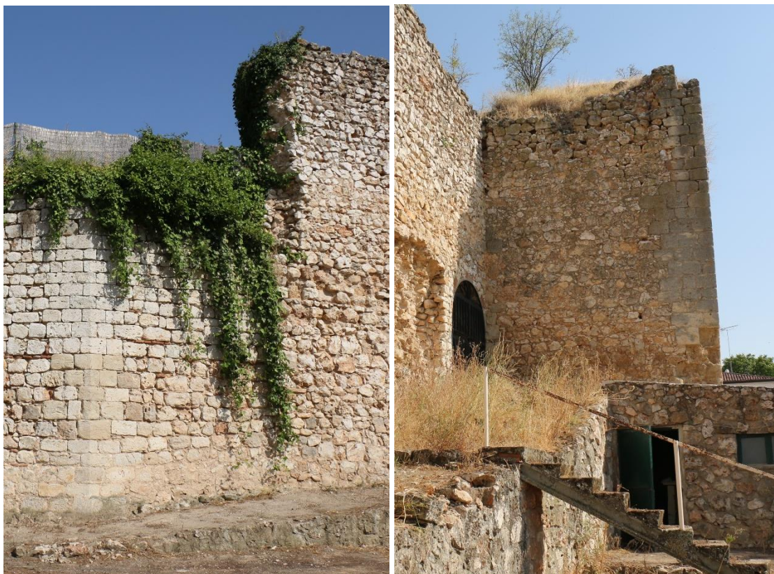
QUI001. Crecimiento de vegetación en coronación de muro y torreón.
