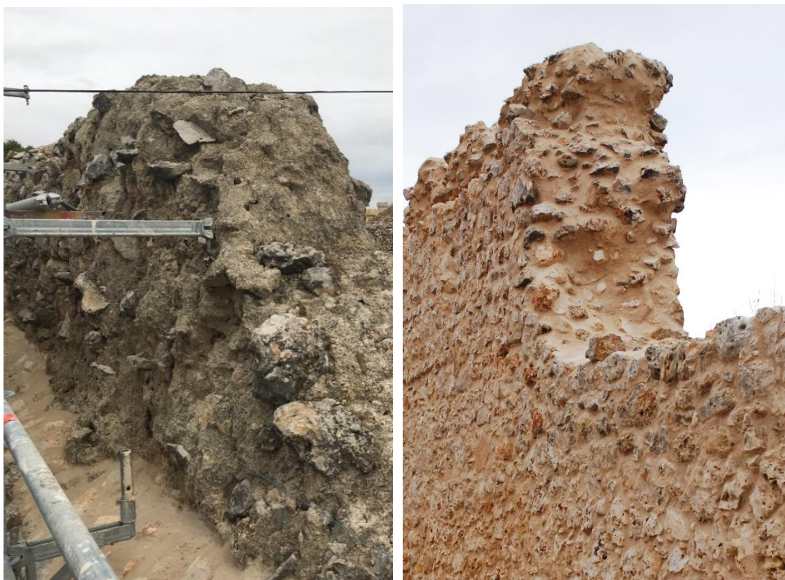
La primera fotografía muestra la sección del tramo intervenido en 2019 durante los trabajos de restauración y la segunda la sección del tramo 2 en la finalización de su intervención.
