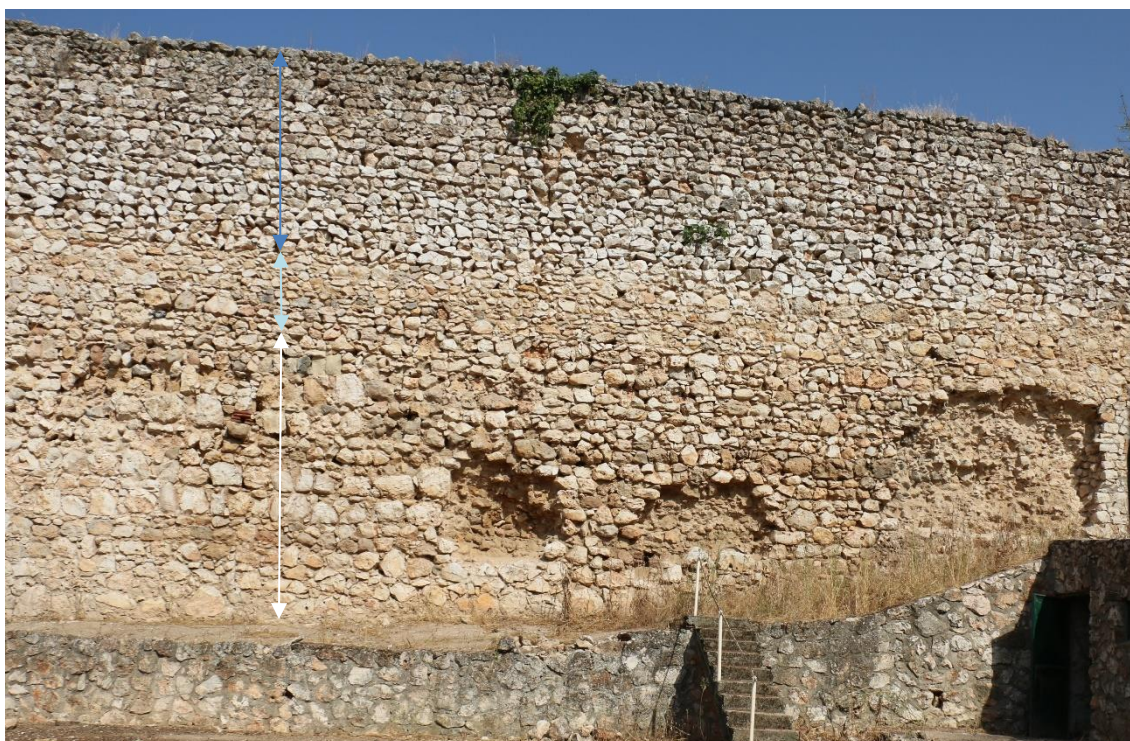
Esta imagen pertenece al lienzo exterior del tramo 3 sobre el que se actúa. Pueden verse diferentes disposiciones de la mampostería.
