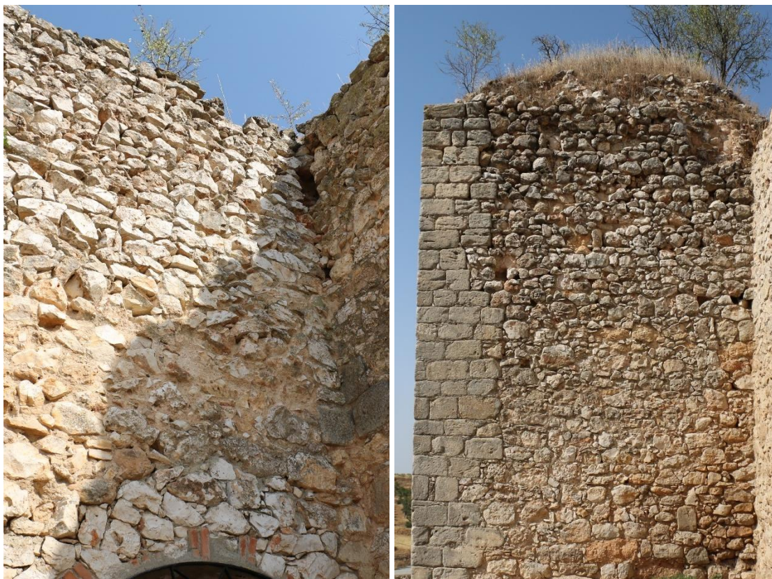
FIS001. Erosión de mortero de cal original en la parte superior de muro y torreón.
