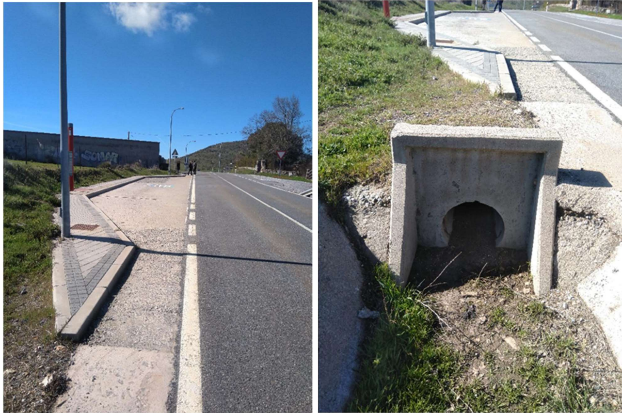
FOTO IZQUIERDA: OBRA DE DRENAJE QUE DA CONTINUIDAD A LA CUNETETA. ZONA DE LA PARADA DE BUS, DESDE DONDE PARTE LA ACTUACIÓN. FOTO DERECHA: PARADA DE BUS. ZONA DE INICIO DE LA ACTUACIÓN.
