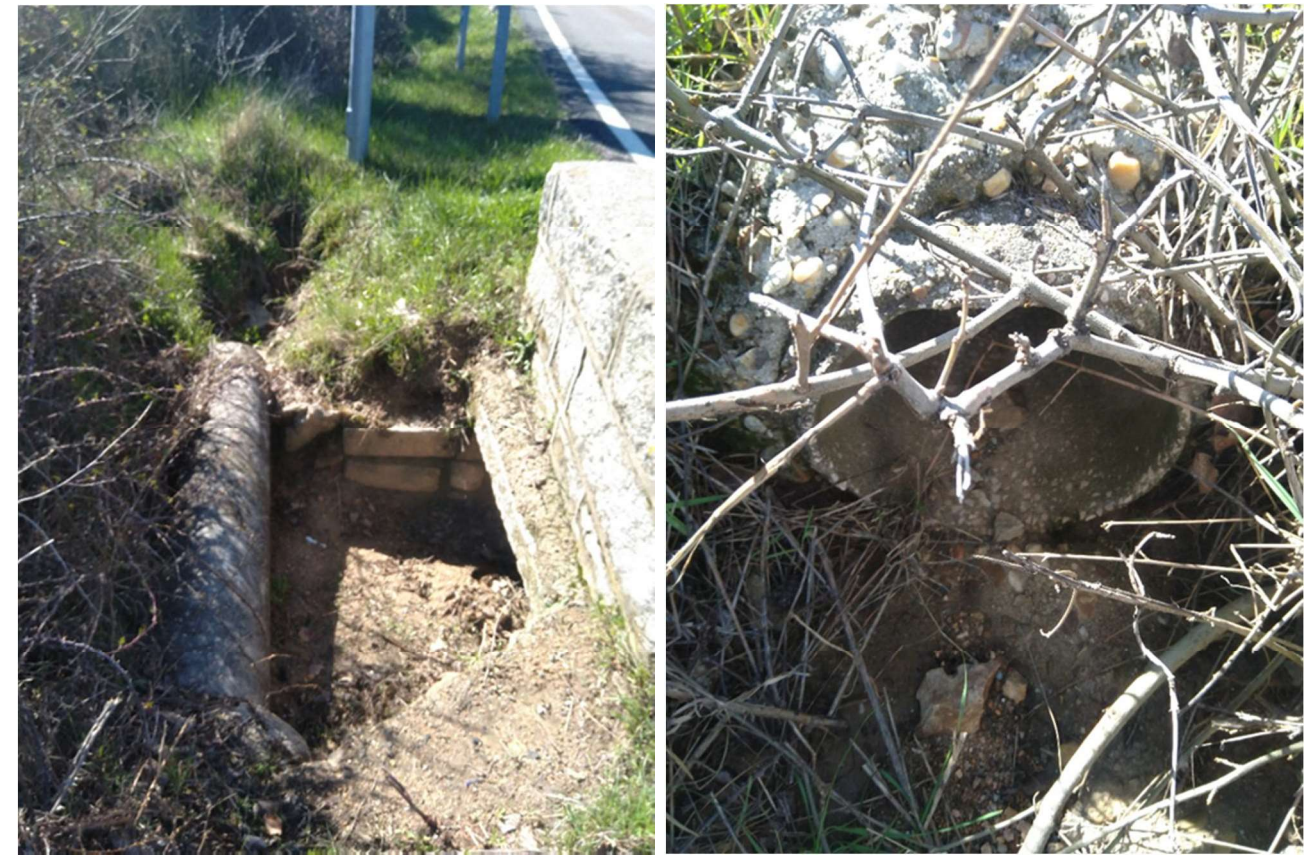
FOTO IZQUIERDA: TUBO SALVACUNETAS FOTO DERECHA: O.D.T. Y TUBO. PRETEL JUNTO CALZADA.
