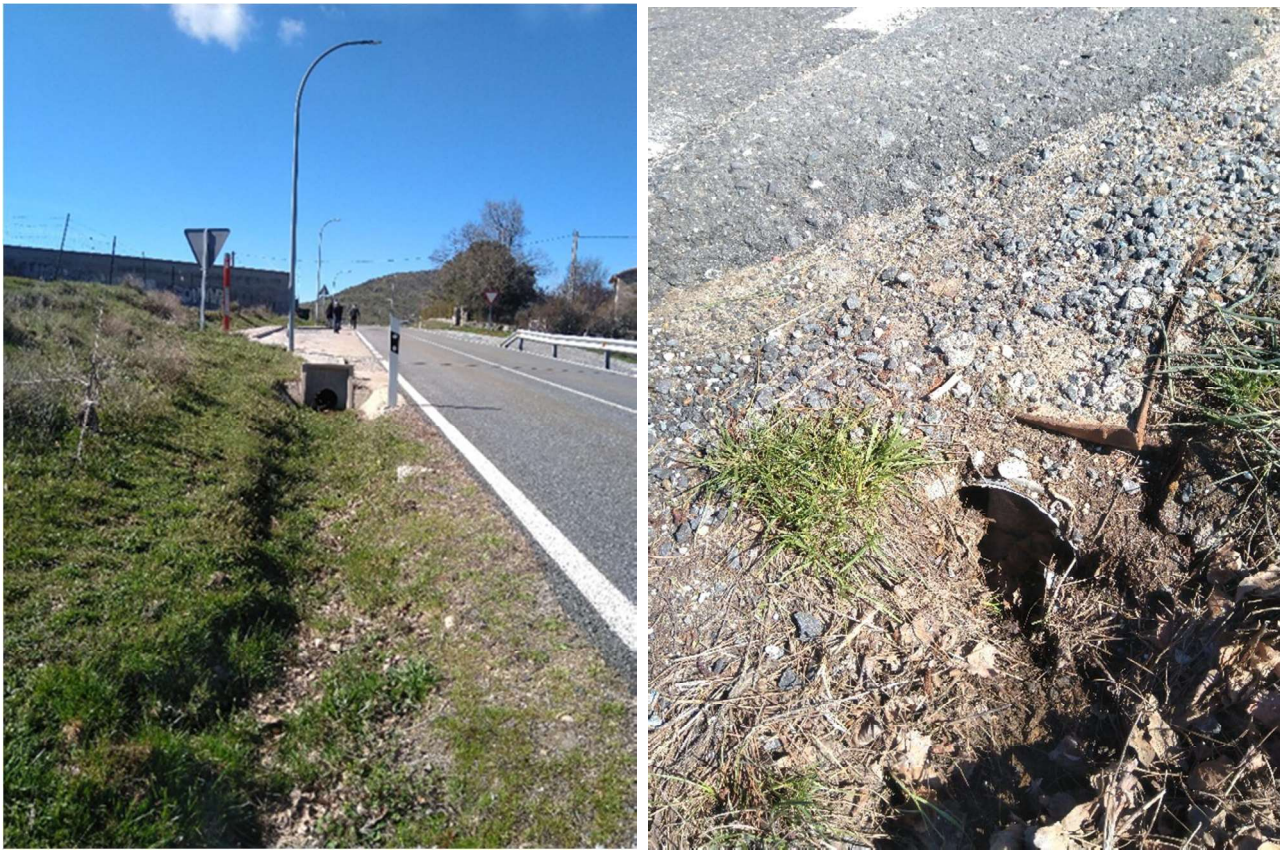
FOTO IZQUIERDA: OTRO TUBO SALVACUNETAS EN EL ACCESO AL CAMINO RUTA DE LOS ARROYOS. FOTO DERECHA: CUNETETA EXISTENTE. AL FONDO PARADA DE AUTOBÚS. TUBO ENTERRADO BAJO ACERA. INICIO DE LA ACTUACIÓN EN LA MARGEN DERECHA DE LA CARRETERA.
