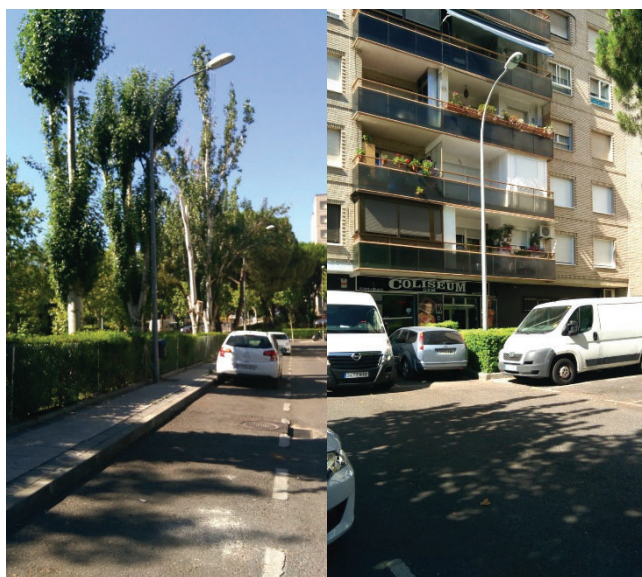
Báculo con brazo simple y luminaria existente
