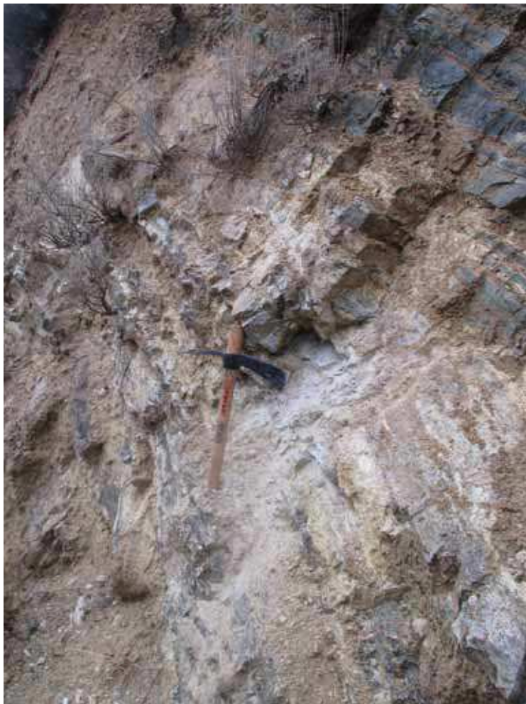
Vista general y detalle del talud de desmonte en roca (neis más o menos alterado).
