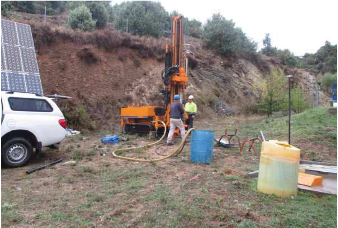
Sondeo S-1 en ejecución. Talud de desmonte en derrubios y roca.
