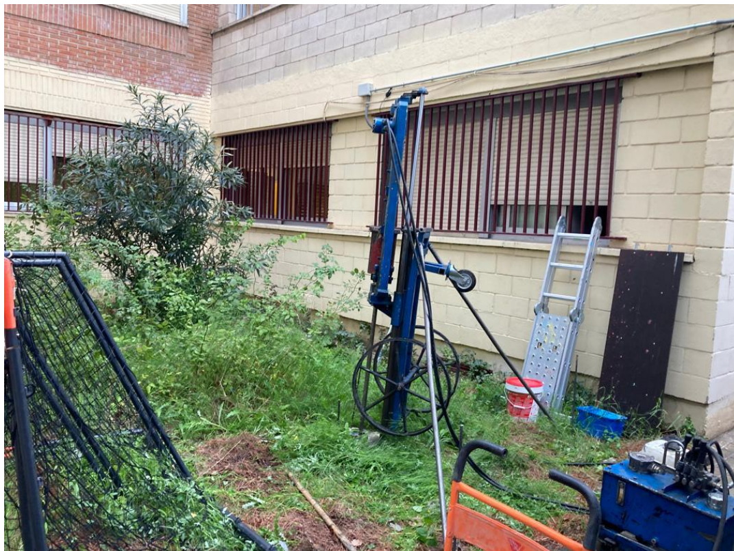
Figura Nº 5.- Trabajos para la realización de la penetración dinámica, tipo DPSH, referida en este documento como P-04.
