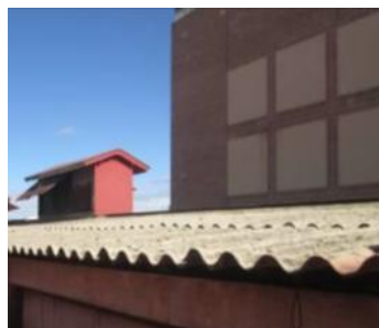
Cubierta de fibrocemento
