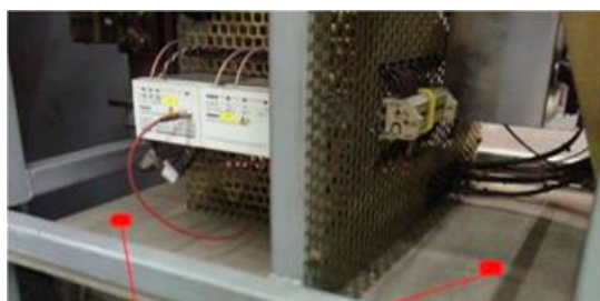
Placas aislantes en equipos eléctricos
