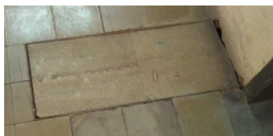
Tapa canal de cables en subestacion eléctrica
