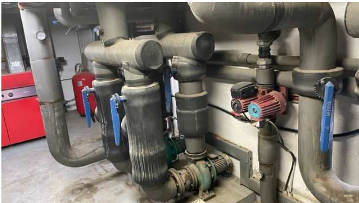
Foto 2 Bombas de recirculación de enfriadora y de climatizador de urgencias
