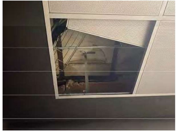
Edificio CRN Cubierta plana sobre pabellón de rayos X (nivel sobre techo planta Bº) vegetación y deficiencias en la tela, que produce humedad en planta inferior
