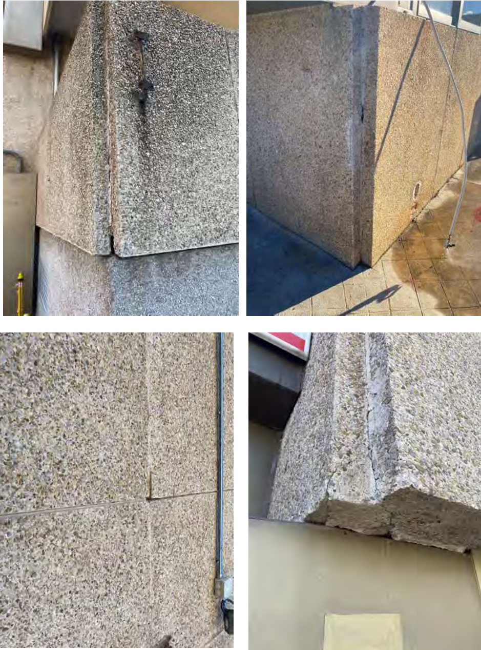
Fotografías de la apertura de juntas en esquinas y fisura en paneles de fachada
