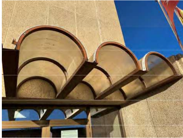
EDIFICIO CRN Signos de oxidación en marquesina de acceso al centro
