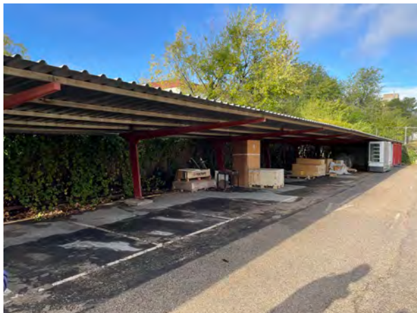
Signos de oxidación en cubierta zona de aparcamiento exterior
