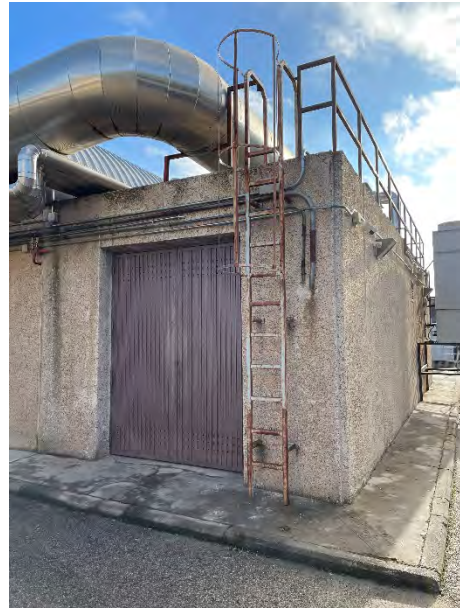
EDIFICIO CRN Signos de oxidación en portones y escaleras verticales en los módulos de talleres e instalaciones
