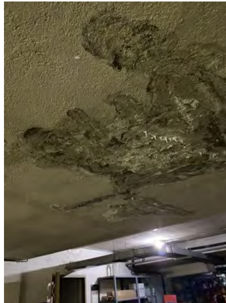
Edificio OE huellas de humedad de cubierta de ascensor y patio interior sobre sótano y humedades en sótano consecuencia del fallo de impermeabilización
