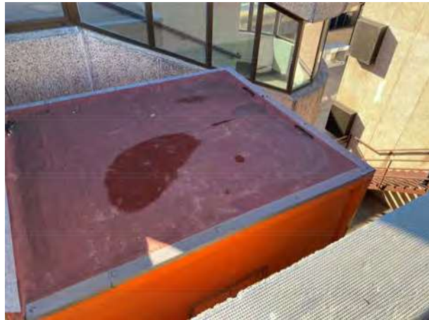
Edificio CRN impermeabilización de casetón de ascensor
