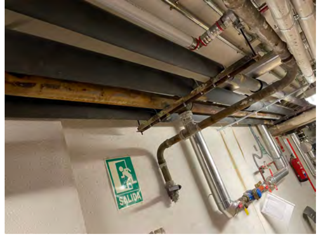
Conducciones sin sustituir en techo de sótano del cuarto de calderas
