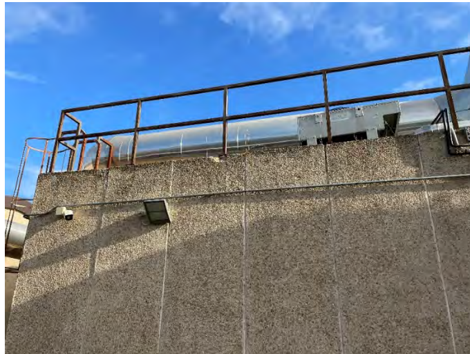
EDIFICIO CRN Rotura del anclaje de la barandilla de cubierta sobre instalaciones
