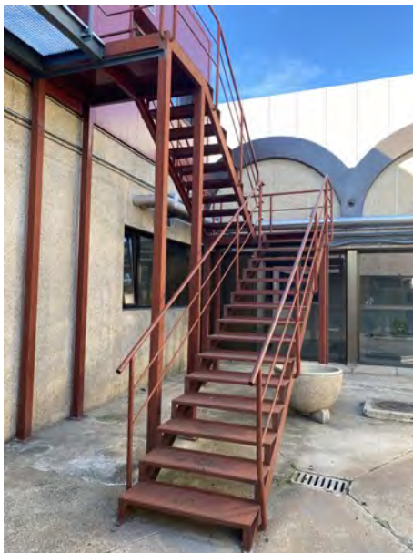
EDIFICIO CRN Signos de oxidación en elementos de escaleras de emergencia en patio
