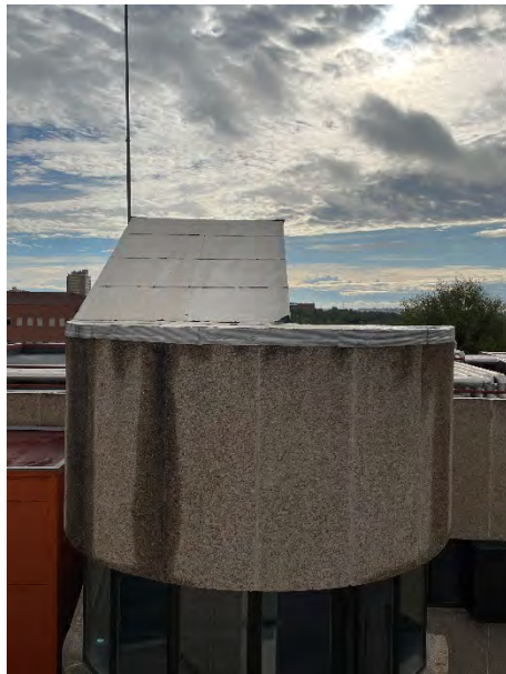
Edificio CRN impermeabilización de casetón de ascensor
