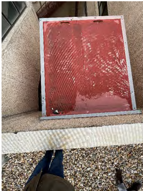
Edificio CRN impermeabilización de casetón de ascensor
