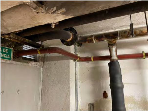
Conducciones sin sustituir en techo de sótano del cuarto de calderas
