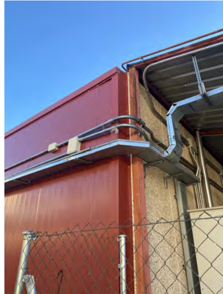
Signos de oxidación en cubierta zona de instalaciones
