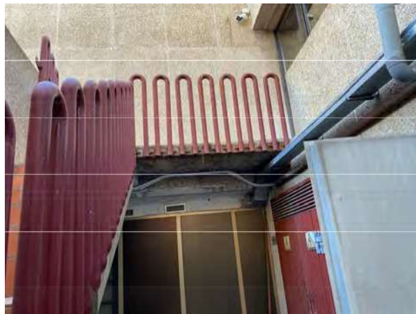
EDIFICIO CRN Signos de oxidación en barandilla bajada a cuarto de calderas
