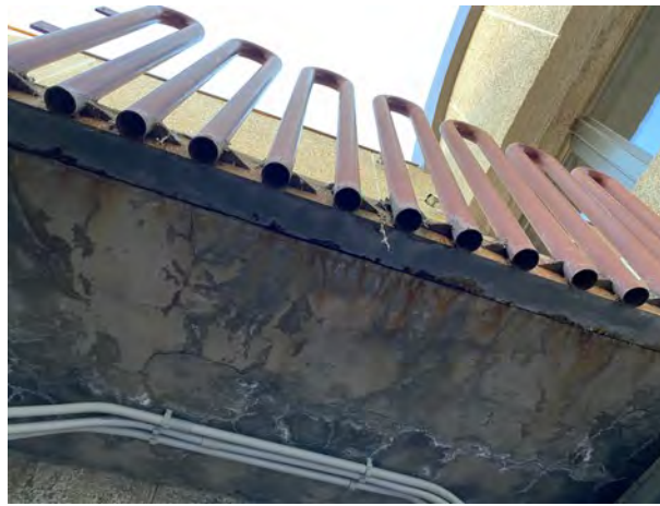
Edificio CRN huellas de humedades en paramentos por carencia de impermeabilización, en escalera de acceso al cuarto de calderas
