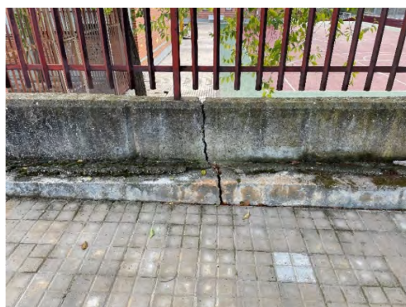
Muro separación parcelas de H.A. desplomado en determinados tramos, fisurado y en mal estado
