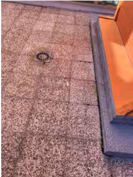
Edificio OE huellas de humedad de cubierta de ascensor y patio interior sobre sótano y humedades en sótano consecuencia del fallo de impermeabilización
