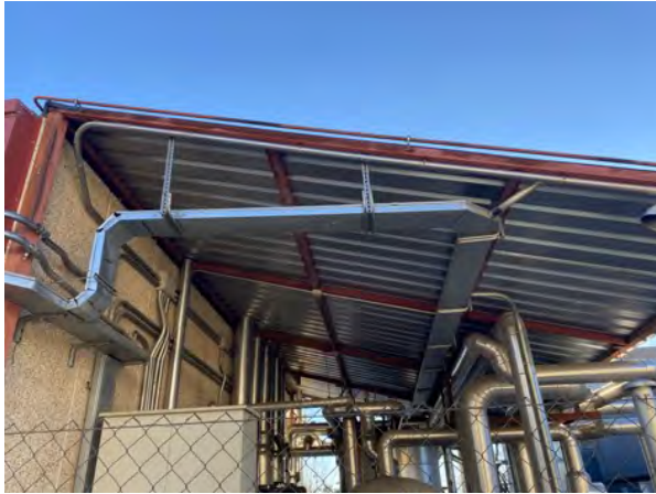
Signos de oxidación en cubierta zona de instalaciones
