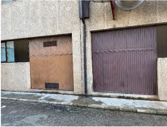
EDIFICIO CRN Signos de oxidación en portones y escaleras verticales en los módulos de talleres e instalaciones
