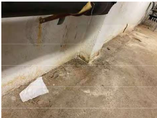
Edificio OE manchas de humedades ya secas en arranque de muros de sótano
