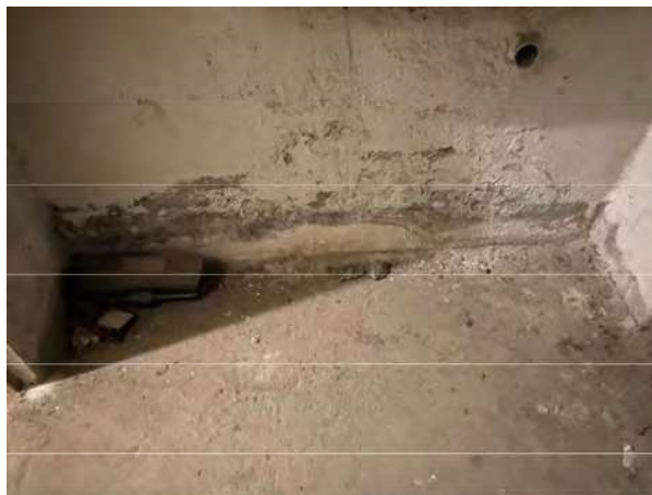
Edificio OE manchas de humedades ya secas en arranque de muros de sótano
