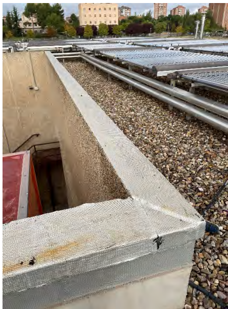
Detalle del murete de cubierta con deterioro de la lámina autoprottegida
