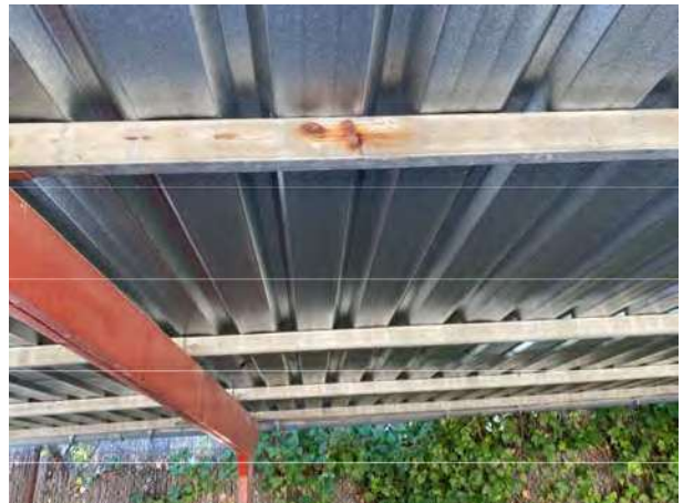
Signos de oxidación en cubierta zona de aparcamiento exterior
