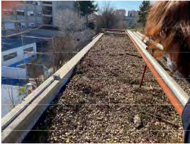
Edificio CRN Cubierta plana sobre pabellón de rayos X (nivel sobre techo planta Bº) vegetación y deficiencias en la tela, que produce humedad en planta inferior
