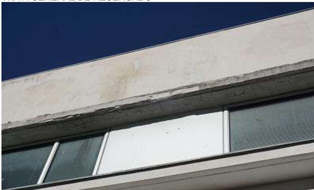
DETERIORO DE REVESTIMIENTO EN RECERCADOS
