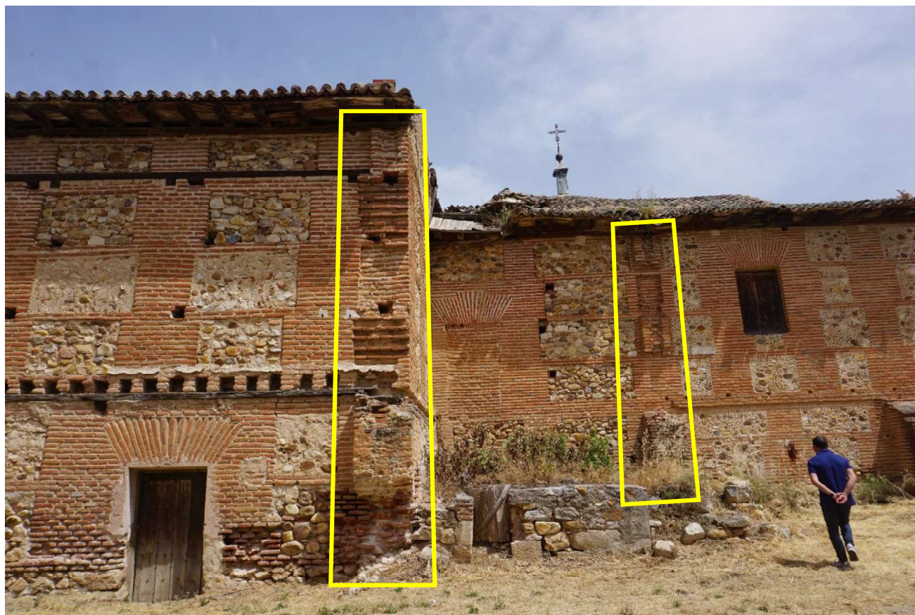
Enjarjes en los muros del lado norte de la crujía oriental
