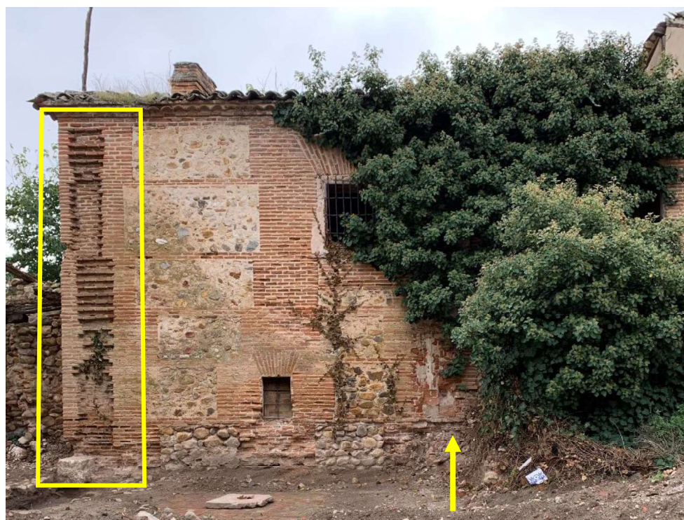
Enjarjes en los muros del lado norte de la crujía oriental
