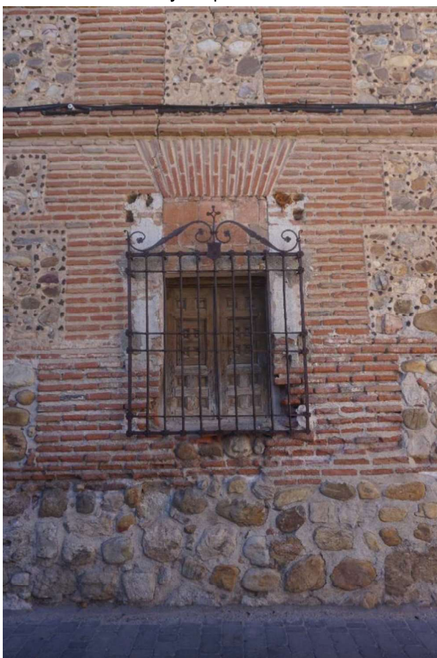
A la izquierda detalle del sistema de cajones y fábrica de ladrillo de la fachada del edificio principal. A la derecha detalle del claustro al cual envuelve el edificio principal
