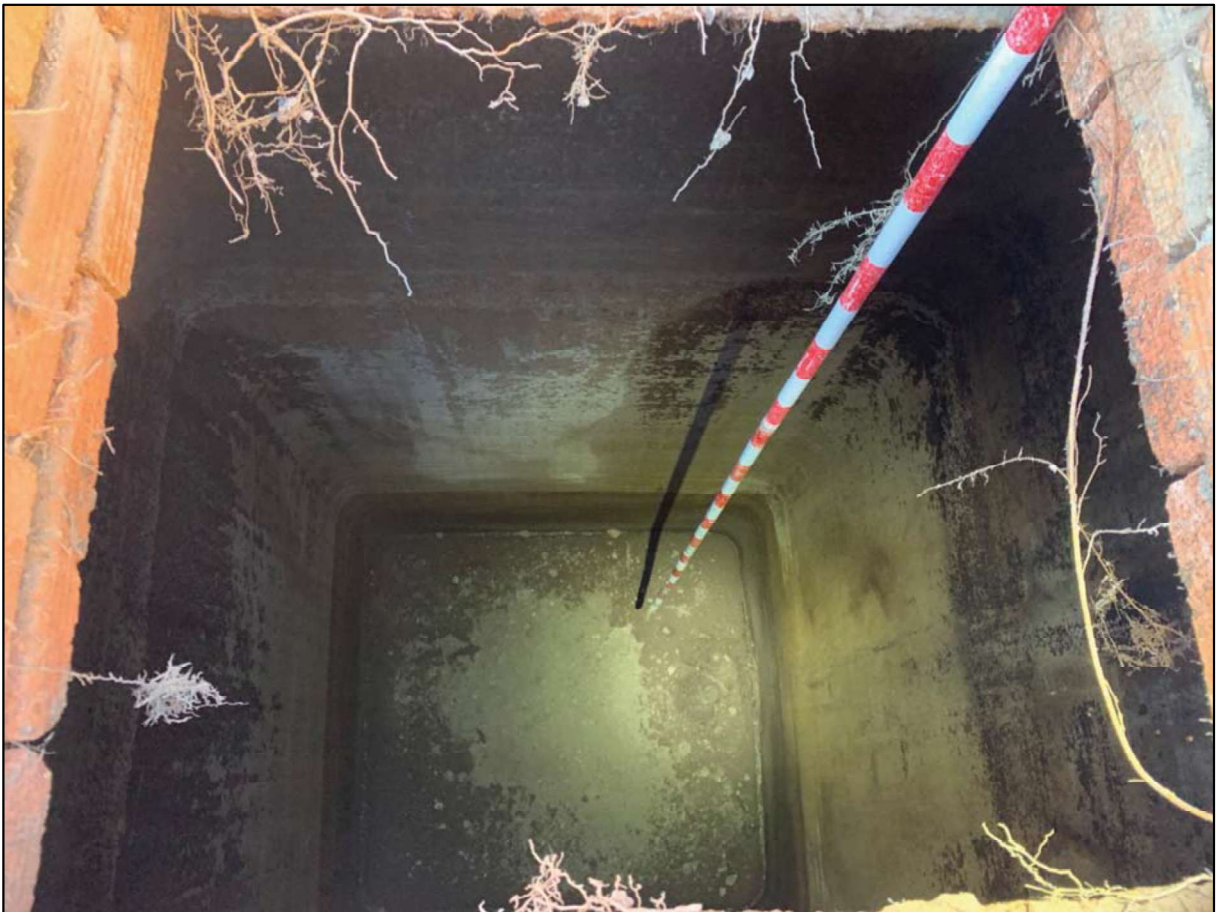
Fig. 21: Vista de las paredes enfoscadas del pozo negro.
