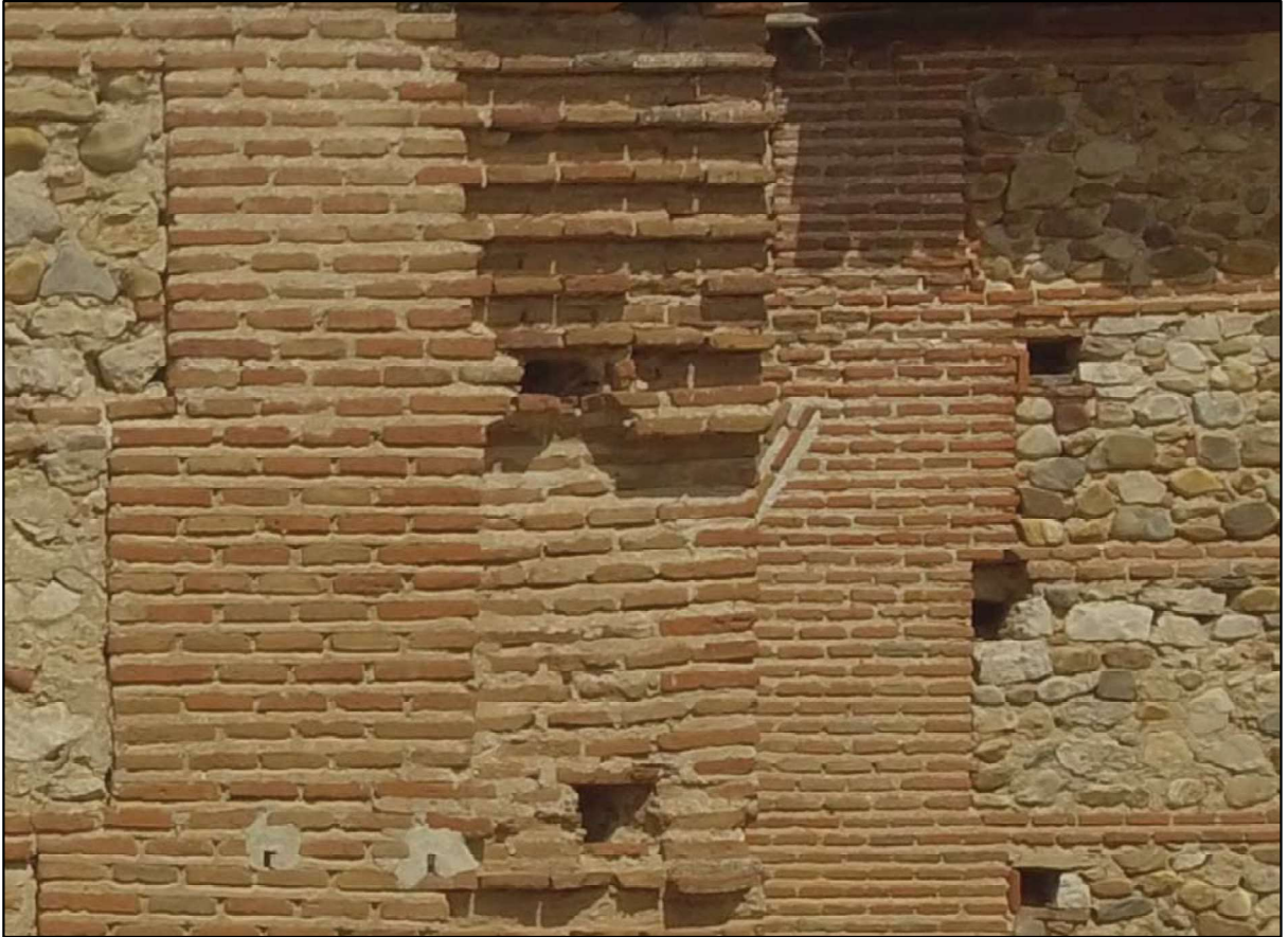
Fig. 50: Detalle de los ladrillos picados para trabar la nueva construcción.
