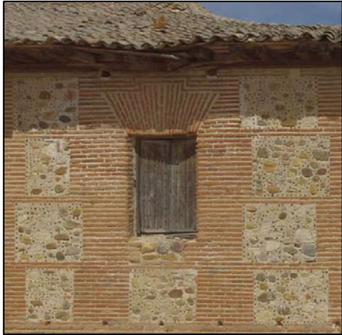
Fig. 31 y 32: Detalle de los cajones y de un vano del edificio central de planta cuadrada (izquierda) respecto de la fachada adyacente (derecha).
