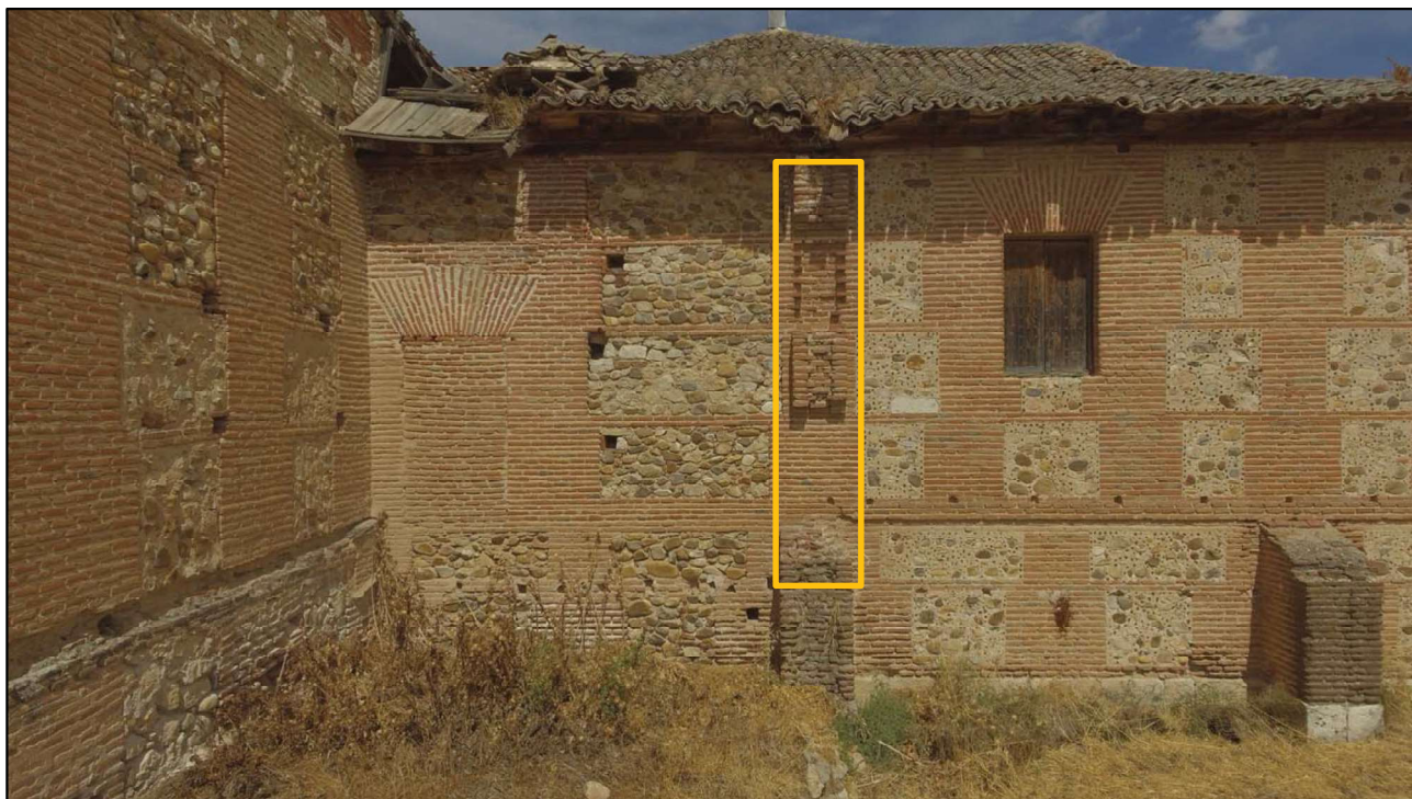
Fig. 33: Imagen en la que se indica la ubicación de la fábrica modificada para el enjarje de una nueva cruzía.
