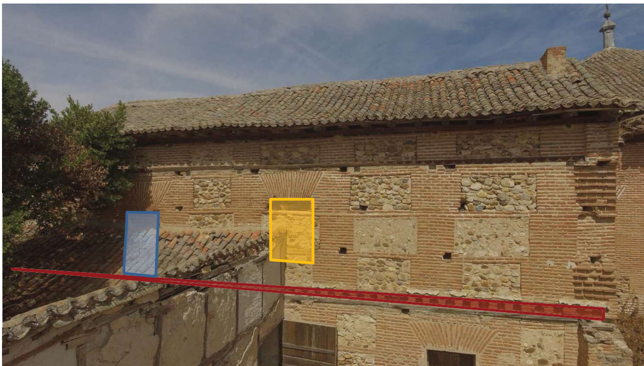
Fig. 45: Fotografía de la fachada norte, ubicación del forjado y de los huecos: puerta (azul) y ventana (amarillo).
