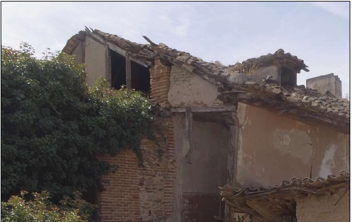
Fig. 40: Detalle de la imagen anterior donde puede apreciarse el adosamiento con mayor claridad.
