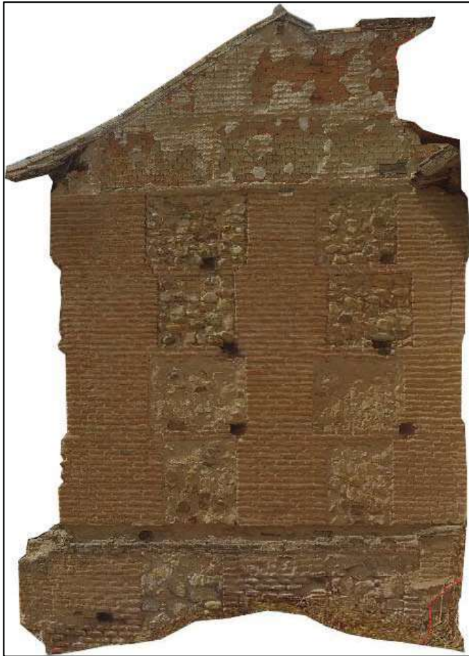
Fig. 35: Alzado fotogramétrico de la fachada de encuentro entre el edificio inicial y el de planta cuadrangular correspondiente con la bodega.
