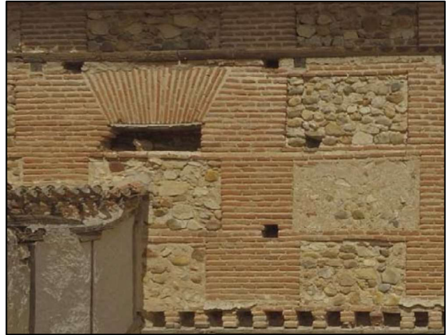
Fig. 31 y 32: Detalle de los cajones y de un vano del edificio central de planta cuadrada (izquierda) respecto de la fachada adyacente (derecha).
