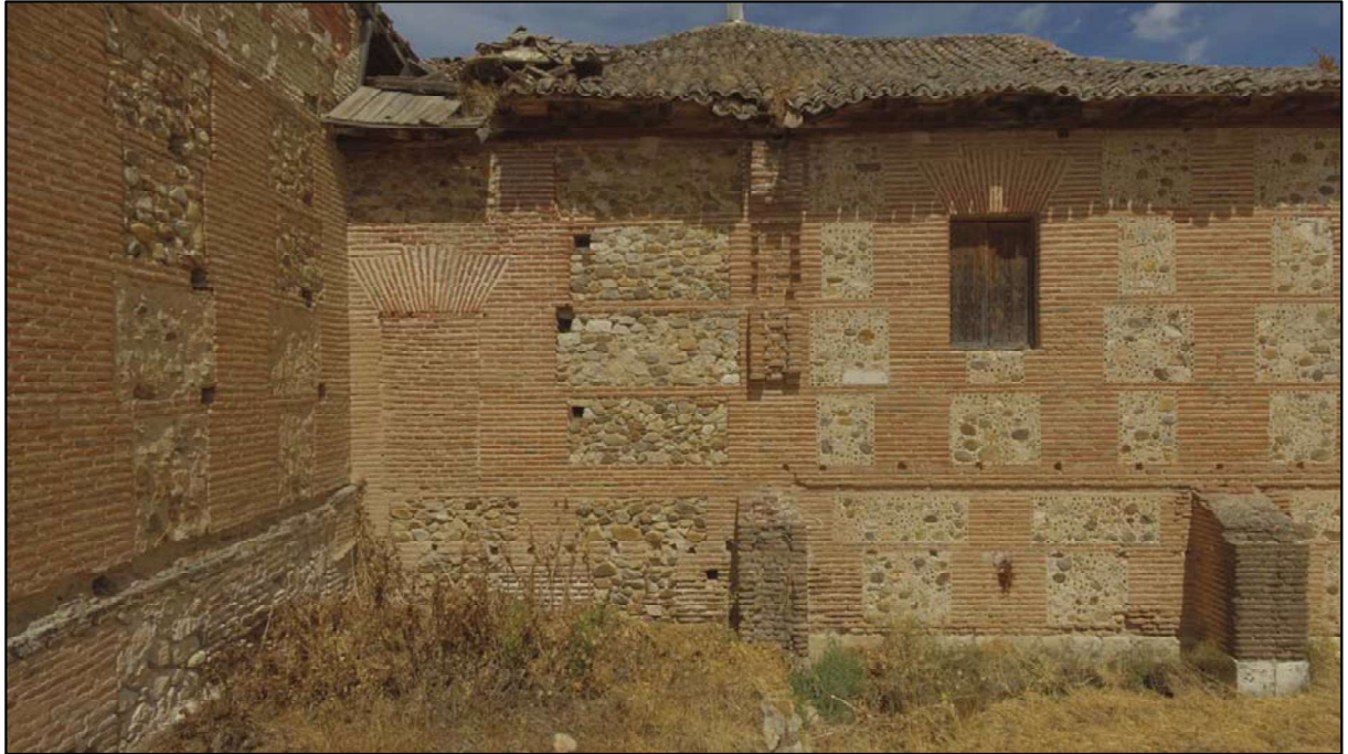
Fig. 36: Imagen que muestra el punto de encuentro de los dos edificios donde puede apreciarse cuestiones como vanos tapiados, diferentes fábricas o esperas de enjarjes de futuras construcciones.
