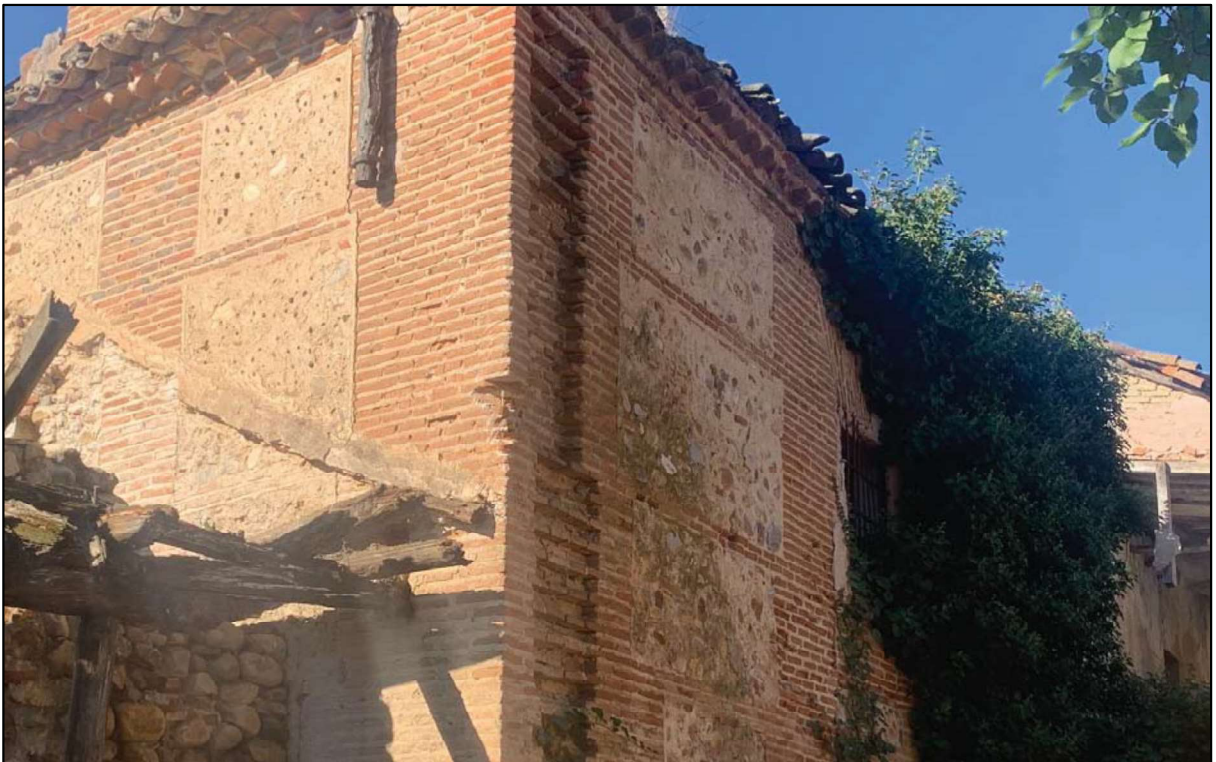
Fig. 51: Detalle de la fachada sur donde puede apreciarse claramente cómo se ha picado el machón de ladrillo para poder enjarjar la fábrica de la nueva cruzja.
