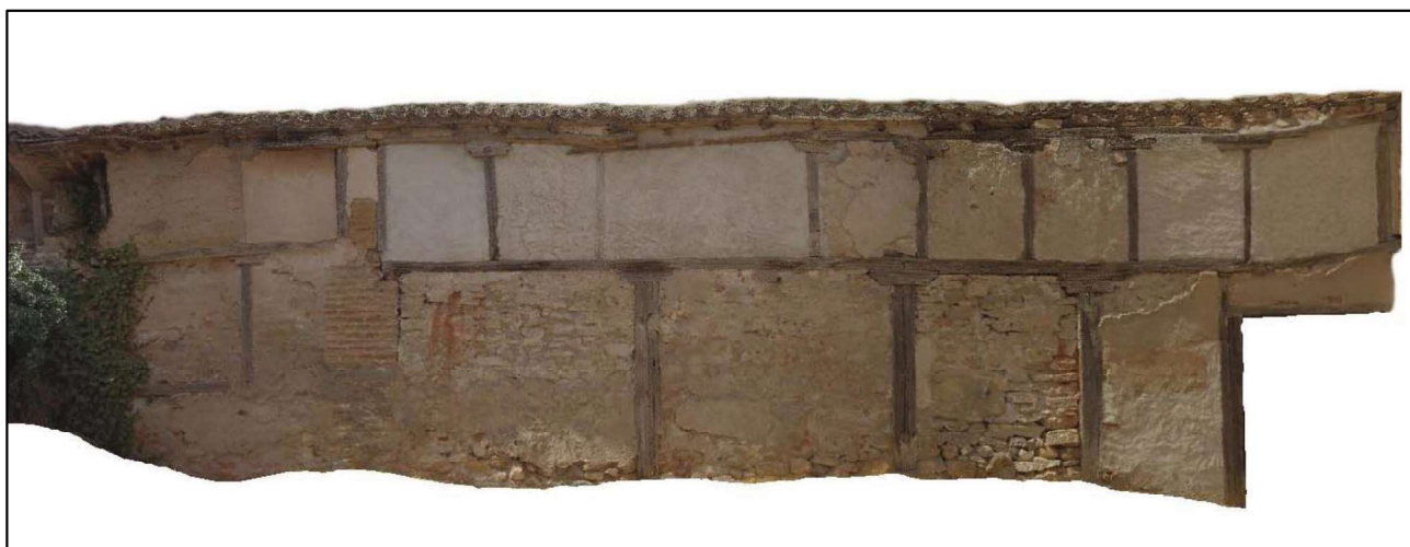
Fig. 41: Alzado fotogramétrico correspondiente al cierre del patio por el Este. Puede apreciarse que su factura nada tiene que ver con el resto de fábricas del edificio objeto de estudio.
