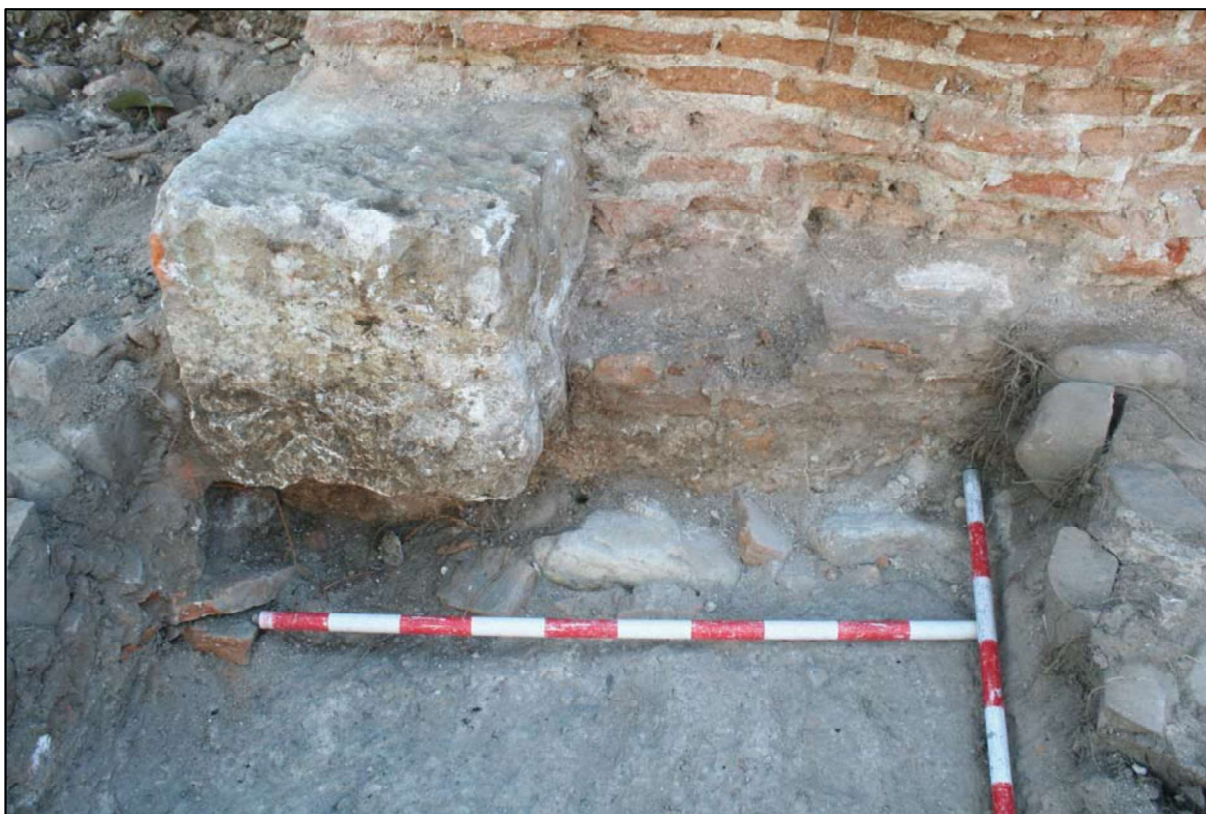
Fig. 109: Vista de la cimentación del muro de La Cartuja documentado en el sondeo sur.
