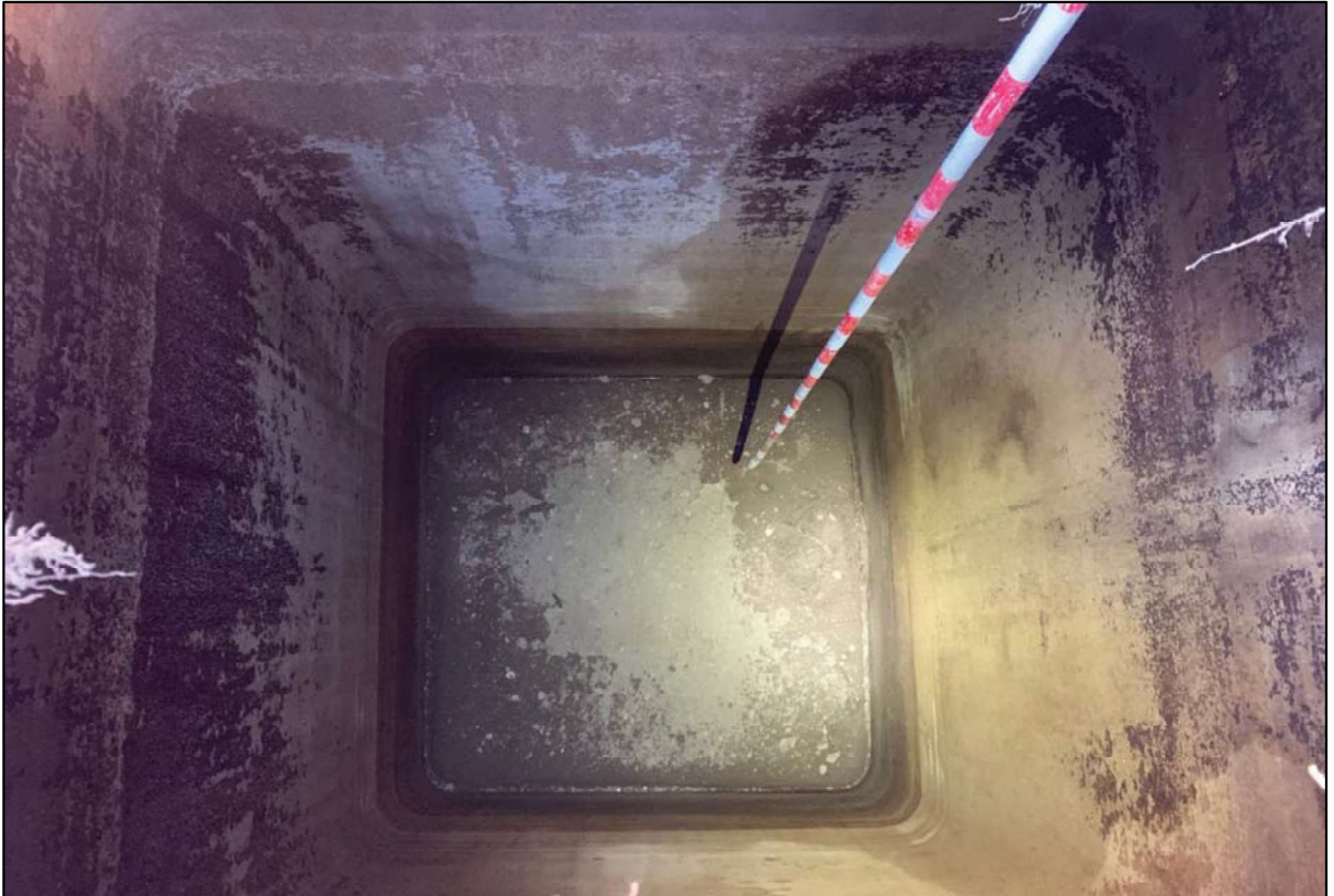
Fig. 102: Vista de las paredes enfoscadas del pozo negro.
