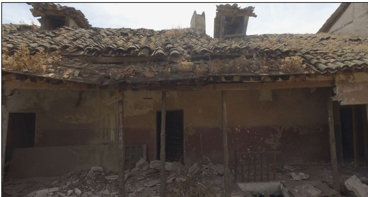
Fig. 27: Detalle de una de las zonas del edificio donde puede apreciarse el mal estado de la construcción.
