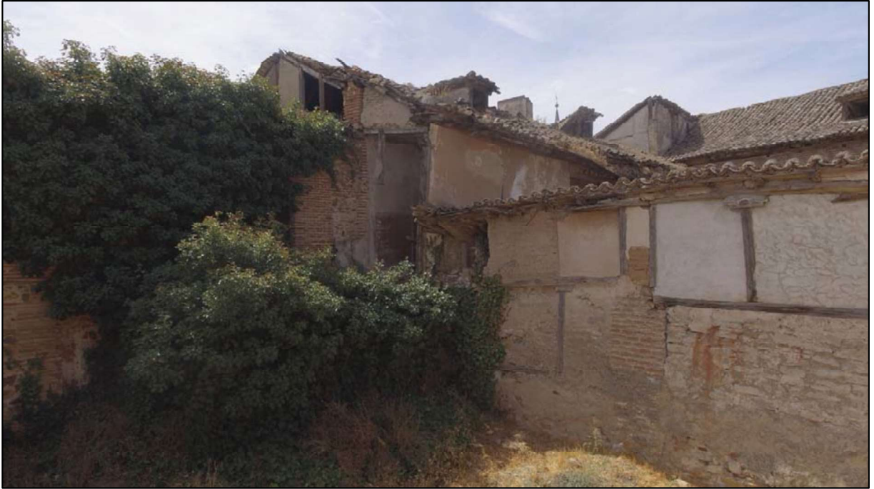
Fig. 39: Vista de la fachada sur de la zona objeto de estudio donde podemos ver cómo se adosa un nuevo cuerpo a la construcción anterior.
