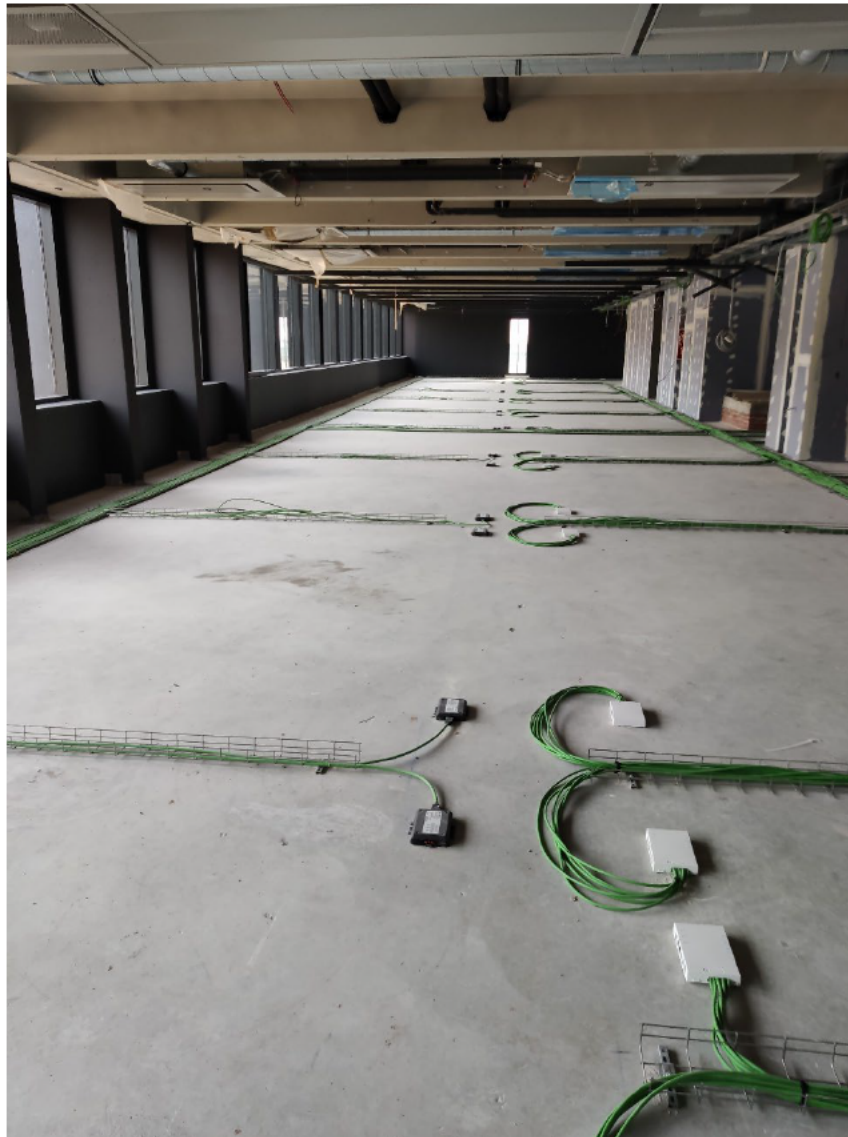
Ejemplo de instalación actual bajo suelo técnico en Edificio CTA de Plaza de Castilla
