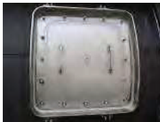
Escotilla de inspección en el tambor interno (400 x 400 mm)
