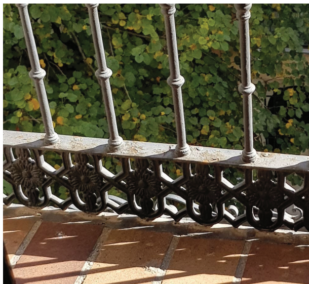
Barandilla oxidada en balcones de fachada principal P. Segunda
