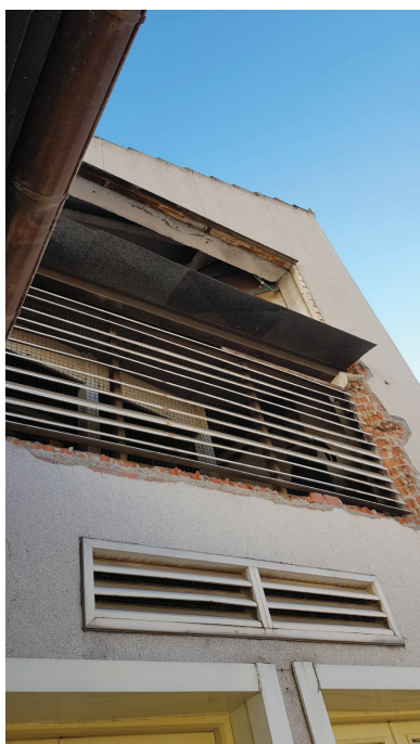
Rejilla en patio izquierdo de máquina de climatización sin rematar en P. Bajo cubierta
