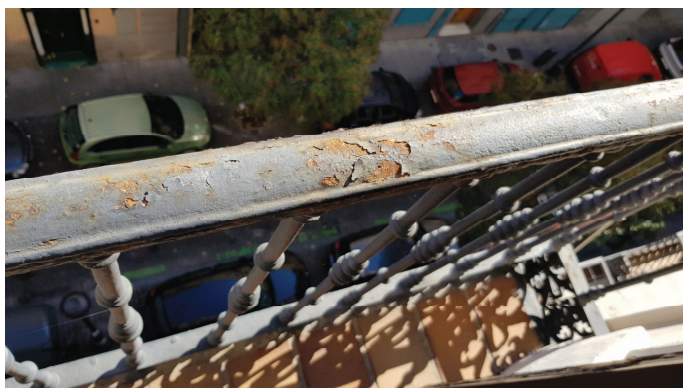
Detalle 2 de barandilla oxidada en fachada principal de P. Tercera
