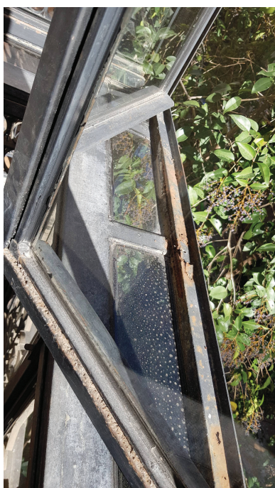
Mirador oxidado en fachada principal P. Primera.
