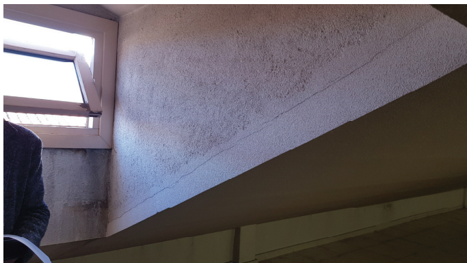
Fisuras en miradores de P. Bajo cubierta
