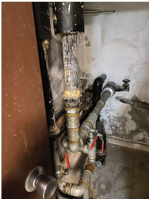
Tubería oxidada en cuarto instalaciones de P. sótano
