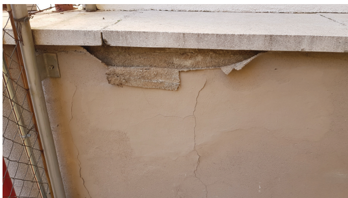
Desprendimiento de monocapa en patio derecho en Entreplanta
