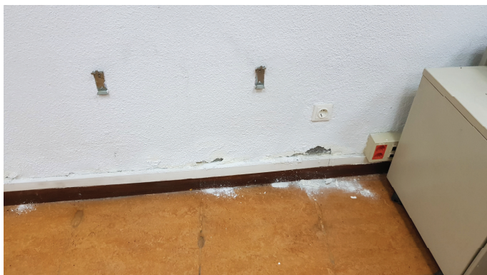
Humedades en el muro de sótano que da al patio interior en el cuarto de montacargas en P. Sótano.
