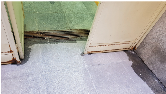
Puerta oxidada en acceso a P. Sótano
