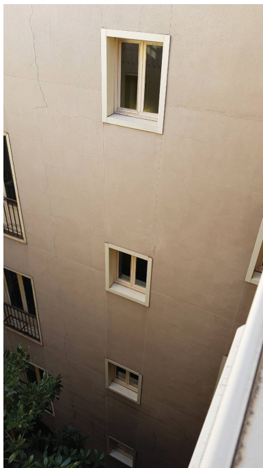
Detalle 2 de fisura en patio interior en todas sus plantas
