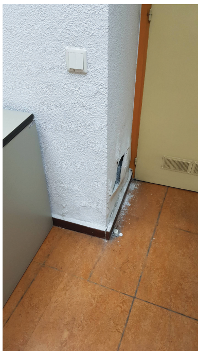
Humedades junto al acceso izquierdo en el cuarto del montacargas de la P. Sótano
