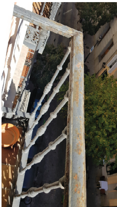
Detalle 1 de barandilla oxidada en fachada principal de P. Tercera
