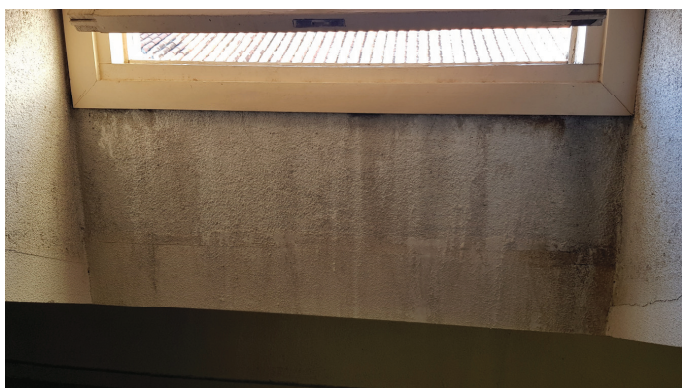
Humedades en mirador en P. Bajo cubierta
