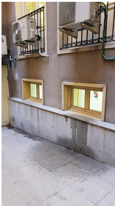
Equipo de climatización sin desagüe en patio interior.
