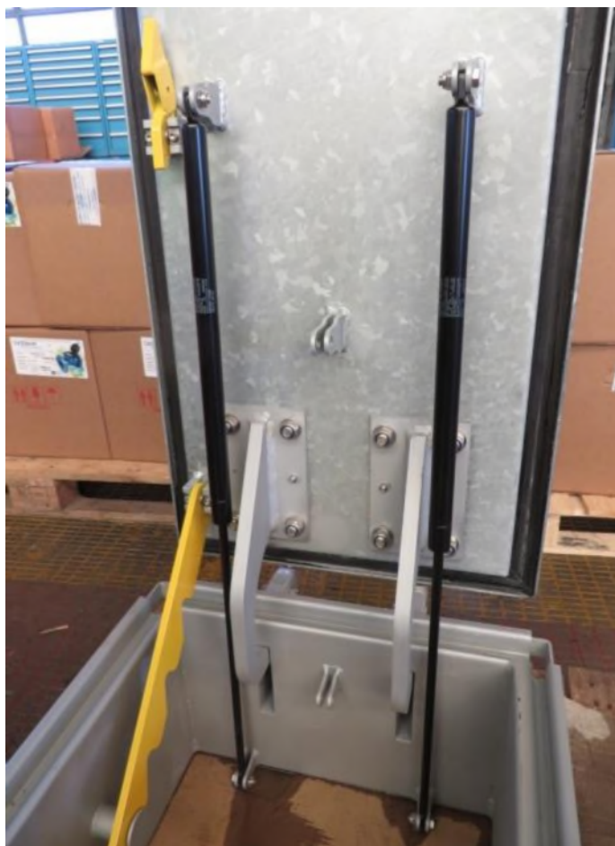
Figura 2. Detalle sistema de apertura y cierre
