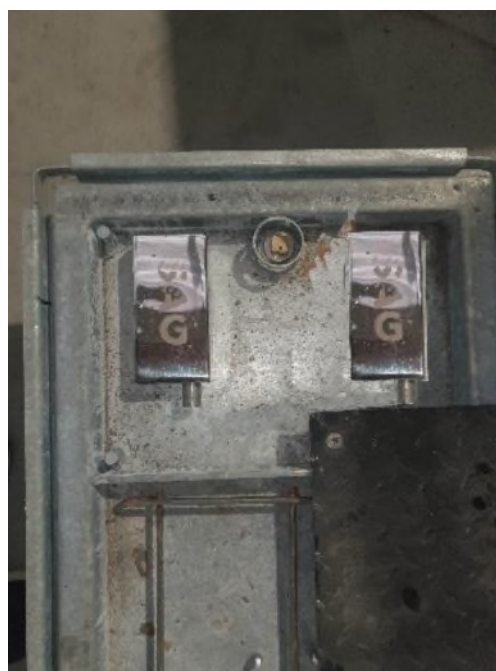
Figura 5. Sistema de cierre parte superior de la arqueta con dos candados SAG
