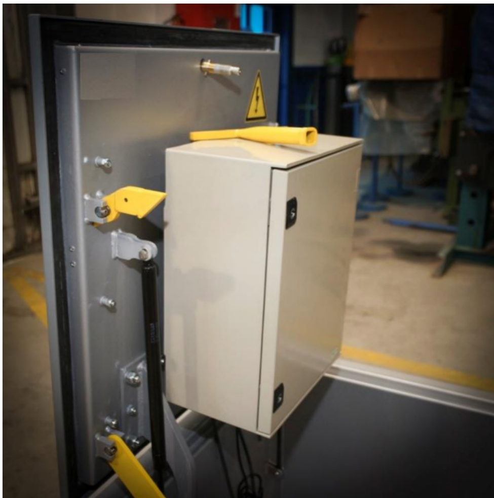
Figura 9. Detalle tapa tipo solar con cuadro de Telemetría instalado
