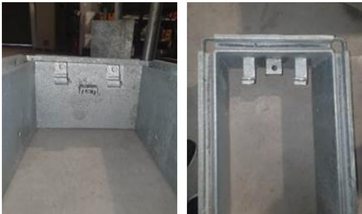
Figura 6. Sistema de cierre parte interior de la arqueta
