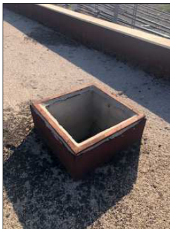
Figura 11: Claraboya vista desde cubierta para salida de chimenea
