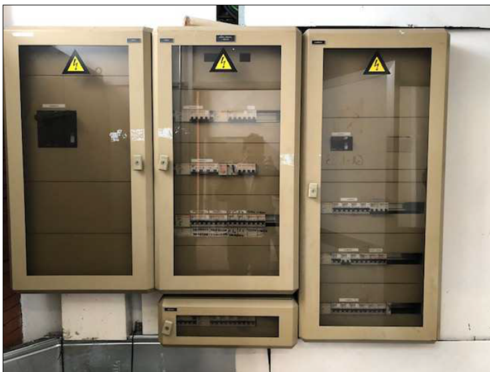
Figura 12: Cuadro de baja tensión existente en nave Laguna 1
