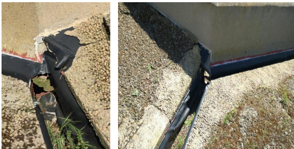
Imagen 6: Detalle falta adherencia en canalones de la cubierta de la SALA DIGESTIÓN Nº 1 EDAR EL MARCO
