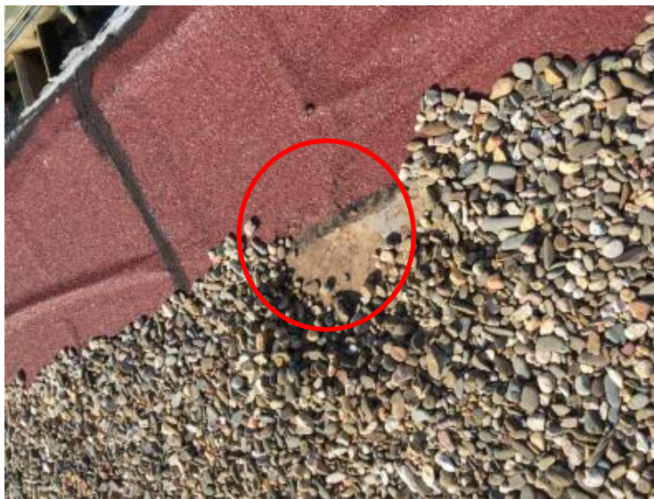
Imagen 4: Detalle falta adherencia entre láminas impermeabilizantes de la cubierta del Edificio de Telecontrol y filtros de arena en la ETAP
