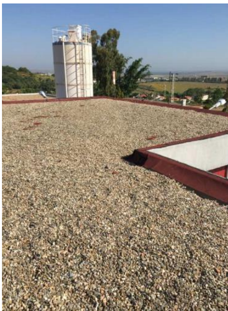
Imagen 1: Cubierta EDIFICIO TELECONTROL Y FILTROS ARENA ETAP. Ejemplo de cubierta con gravilla
