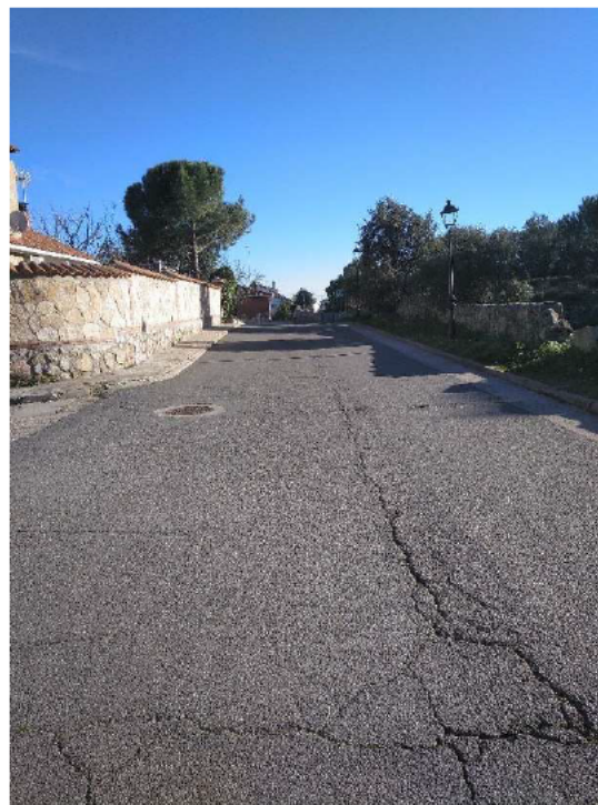
Avenida del polideportivo entre las calles Soto (a la izquierda) y Madrid. Fisuración longitudinal y transversal de la capa de rodadura.
