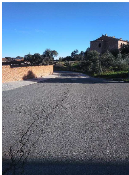
Estado del pavimento en el cruce de la avenida del polideportivo con la calle Bellomonte (a la derecha) con fisuración longitudinal principalmente.
