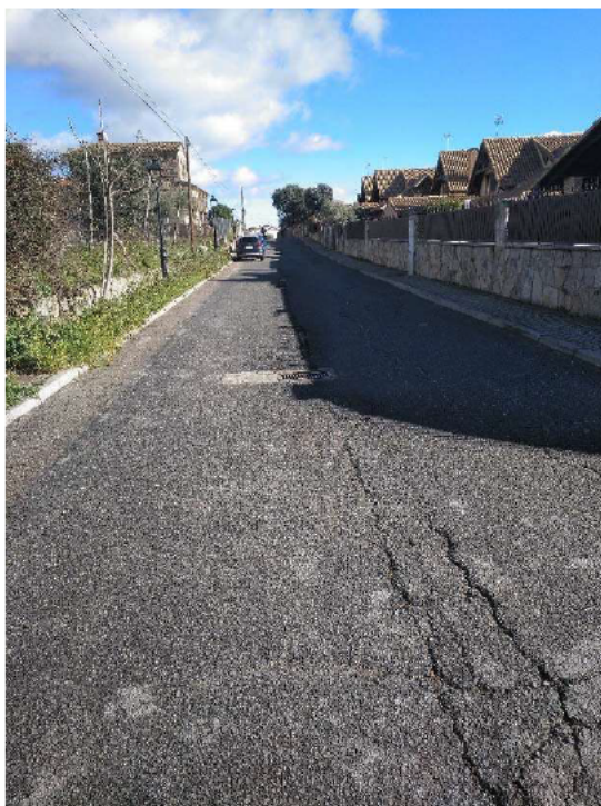
Calle Madrid en el tramo entre los números 23 y 25 (parcelas a la izquierda). Fisuración longitudinal en la capa de rodadura.
