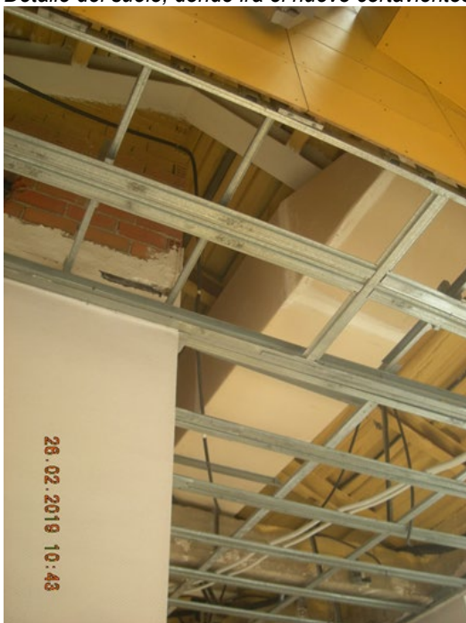
Falso techo levantado durante las obras (2019) antes de que se pintara de oscuro, viéndose instalaciones obsoletas a desmontar
