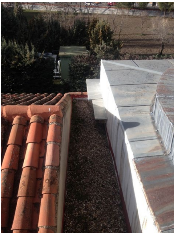
Encuentro de las cubiertas de la Galería y de la Rotonda
