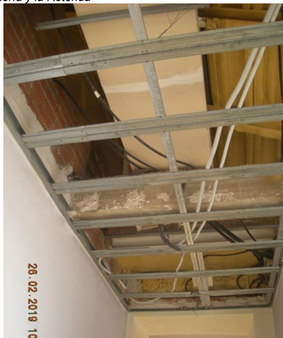
Falso techo levantado durante las obras (2019) antes de que se pintara de oscuro, viéndose instalaciones obsoletas a desmontar
