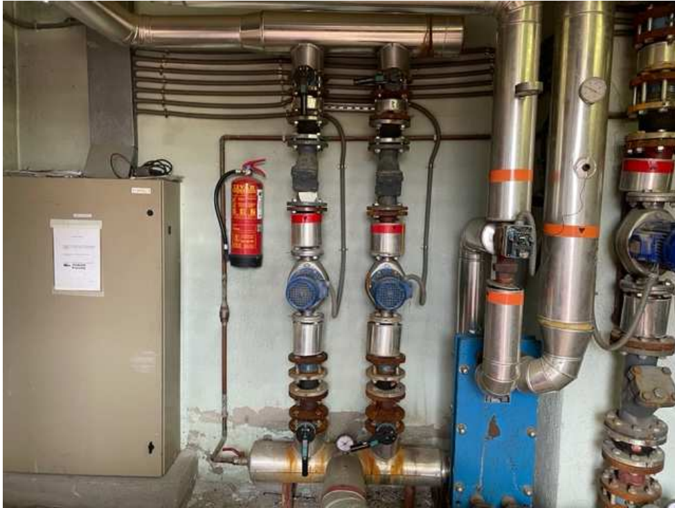
Foto 4 Vista de bombas de primario e intercambiador de placas
