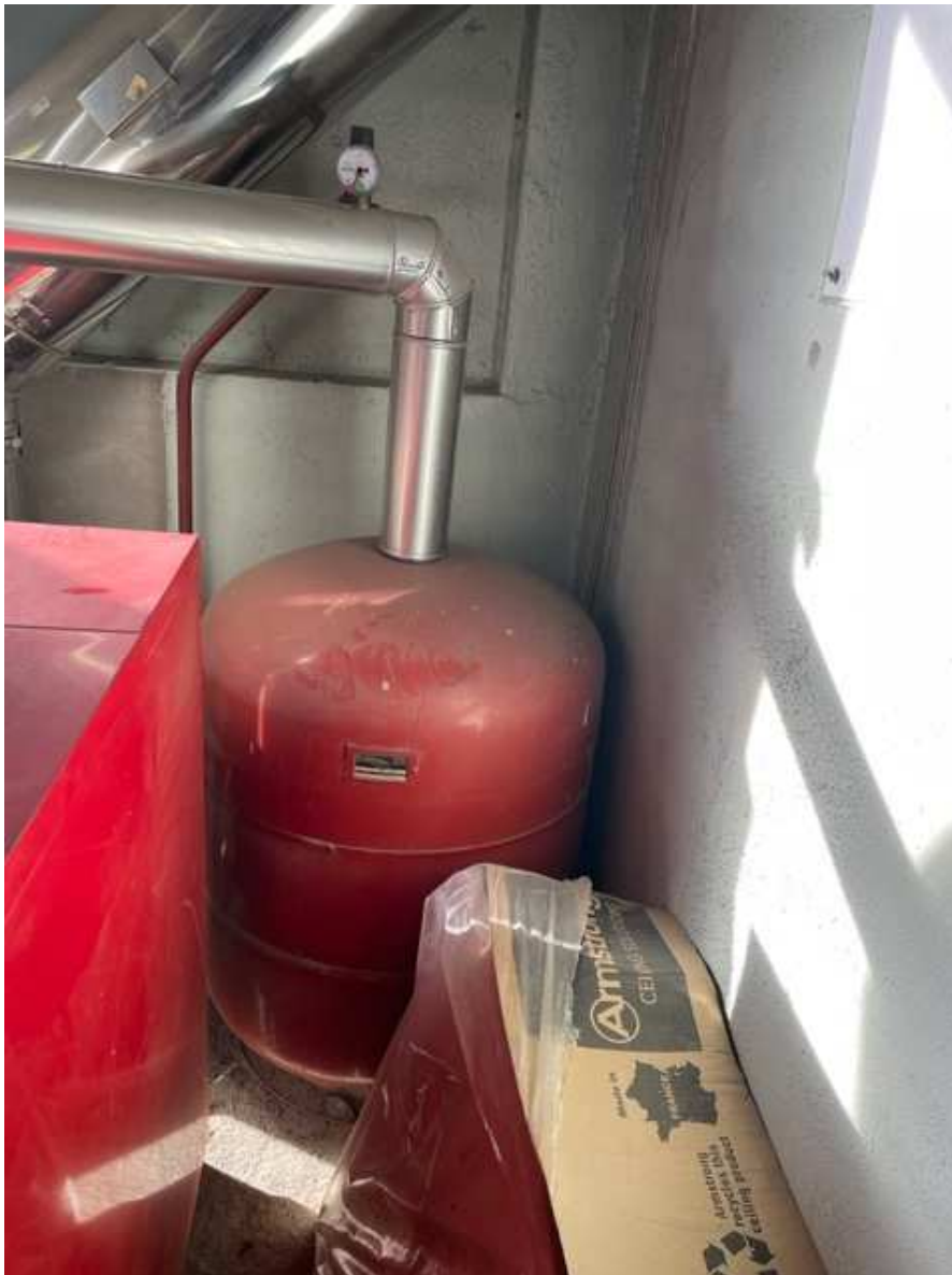
Foto 6 vista de vaso de expansión en circuito primario de caldera
