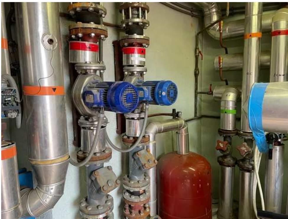
Foto 5 Vista de bombas de distribución a fancoils
