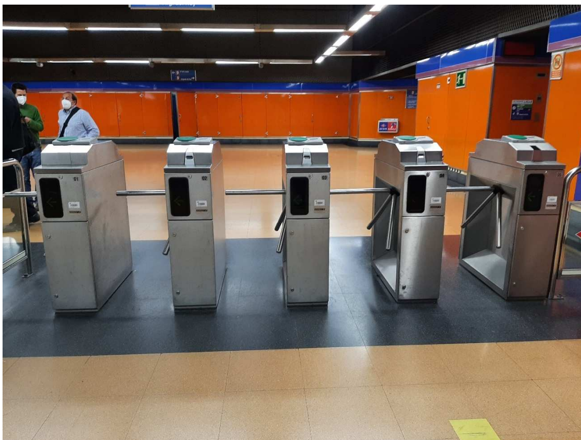
Figura 91: Batería actual de torniquetes de peaje
