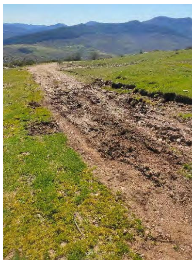
Fotografía 22. Zona de aporte de piedras y de configuración nueva del camino
