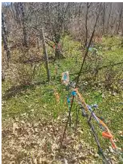
Fotografía 1. Postes de madera ladeados y viejos, postes de madera sustituidos provisionalmente por ferrallas y sustitución del alambre original por cuerdas y otros elementos
