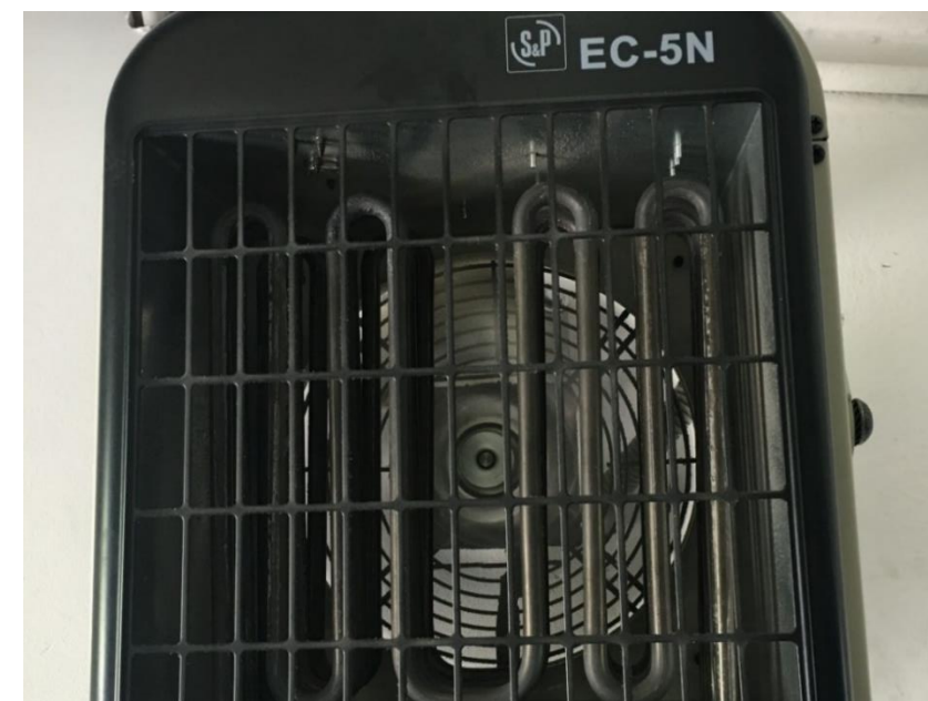
Figura 4. Aluche – Aerotermos eléctricos situados en los Vestuarios de la Planta Baja
