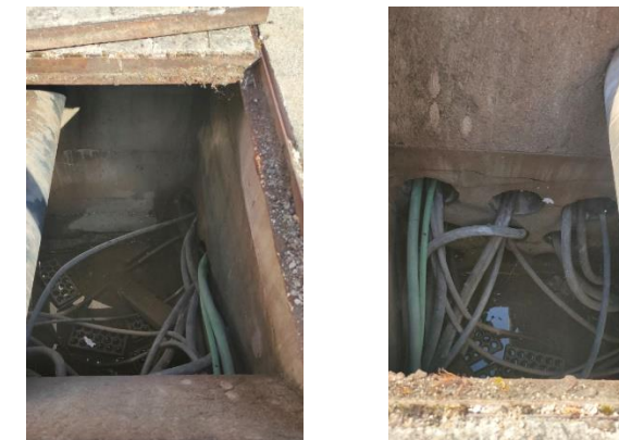
Fig. DE.4 – Arqueta final existente con conexión a CGBT
