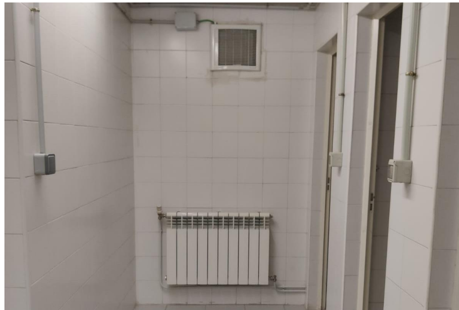
Figura 1. Almendrales – Ventilador axial y radiador situado en el Aseo Femenino
