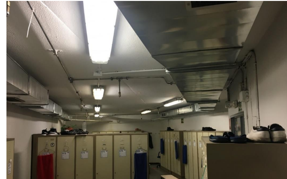
Figura 1. Gregorio Marañón – Conductos de ventilación existentes en el Vestuario Masculino.
