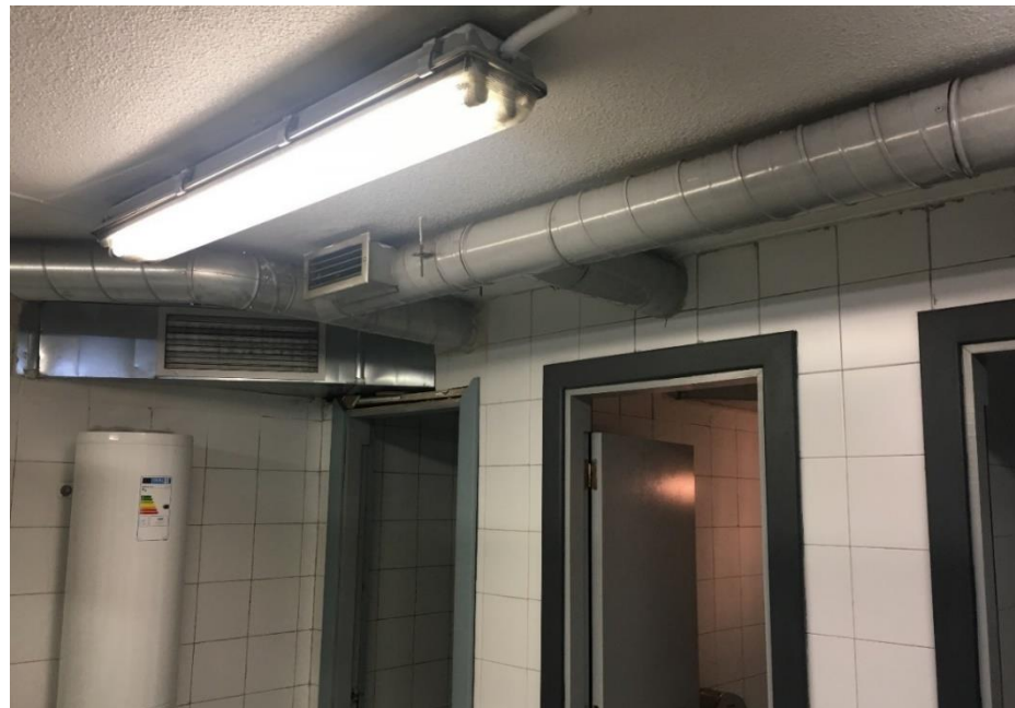
Figura 3. Gregorio Marañón – Impulsión y extracción existentes en núcleo de Aseos.
