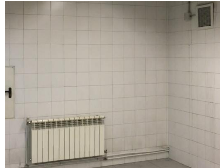
Figura 3. Almendrales – Ventilador axial y radiador situados en el Vestuario Masculino
