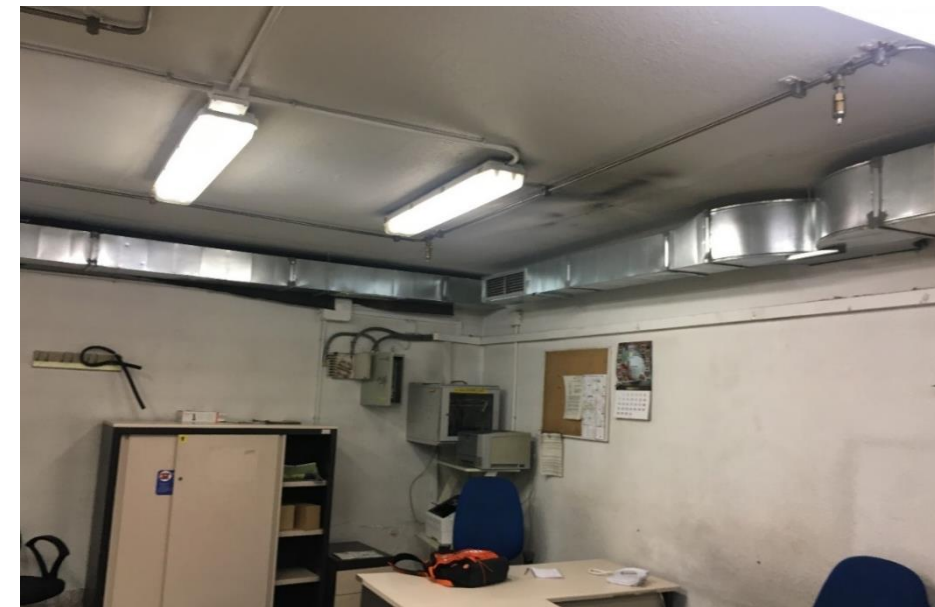
Figura 2. Gregorio Marañón – Conductos de ventilación existentes en la Oficina.
