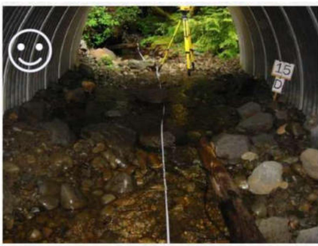
Figura 25 Ejemplo de obra de drenaje correctamente adaptada en el cauce. Fuente: Anastasio Fernández Yuste
