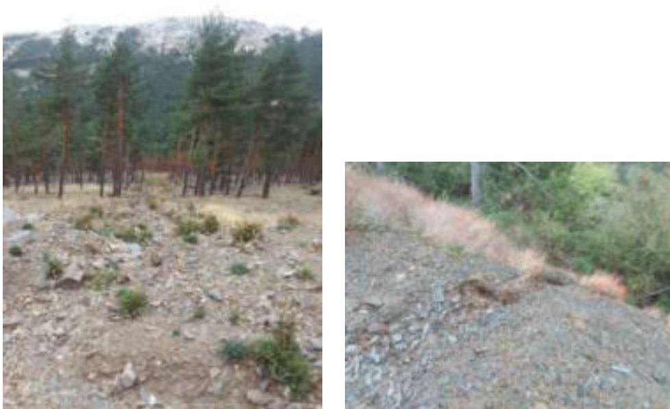
Figura 22 Efectos de los fenómenos erosivos producidos en las laderas por falta de drenajes transversal y longitudinal adecuados.
