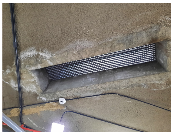
HUMEDADES BAJO LA REJILLA DE VENTILACIÓN DEL ALMACÉN
