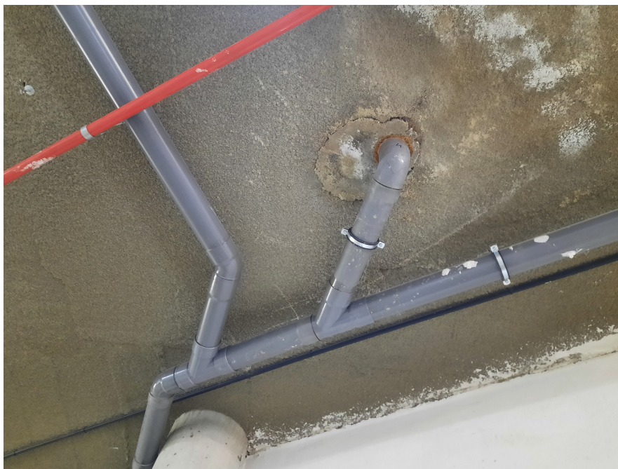
SÓTANO: HUMEDADES EN TECHO Y RED DE COLECTORES COMPLICADA
