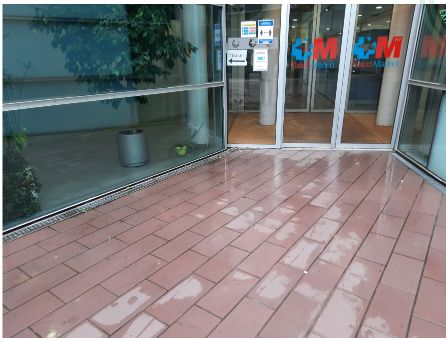
DEFICIENTE ESTADO DE LA REJILLA EN LA ENTRADA A LA DGSIS
