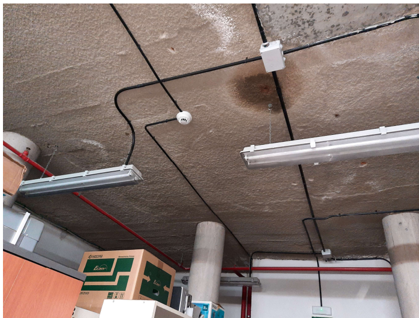
GOTERA EN EL TECHO DEL ALMACÉN CESUS
