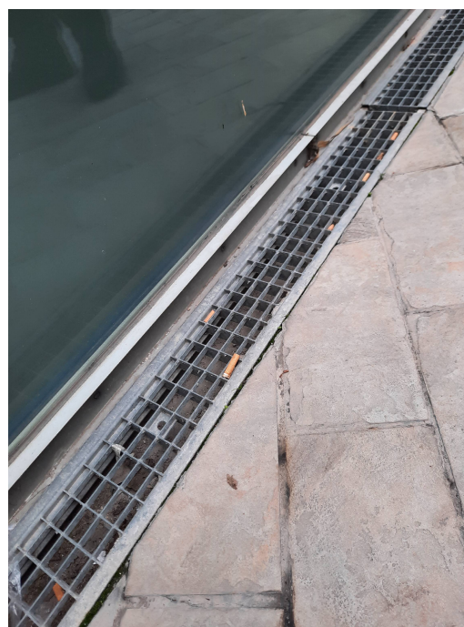
CANALETA DE RECOGIDA DE AGUAS PLUVIALES
