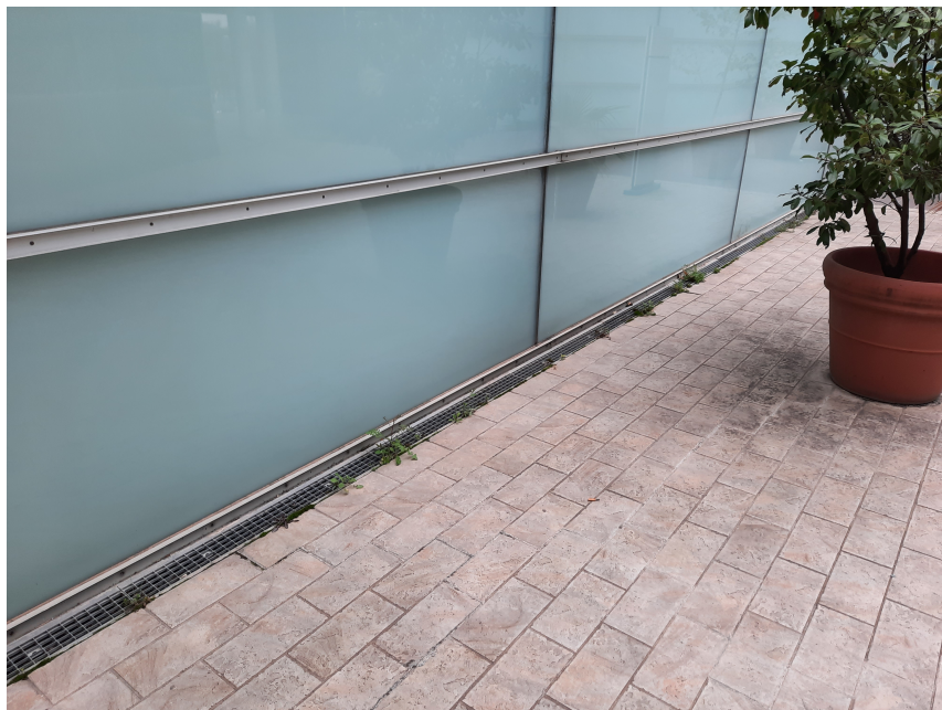
PRESENCIA DE VEGETACIÓN A LO LARGO DE LA CANALETA PERIMETRAL
