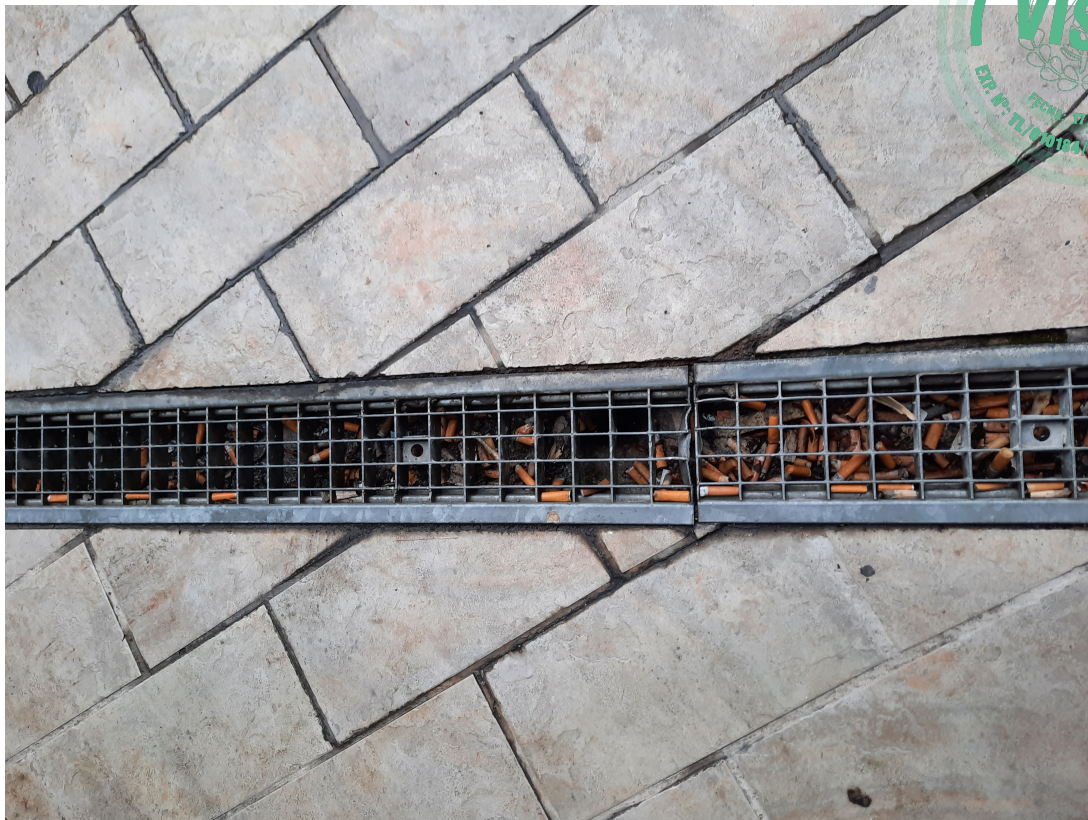
ACUMULACIÓN DE RESIDUOS EN LA REJILLA PERIMETRAL DEL PATIO
