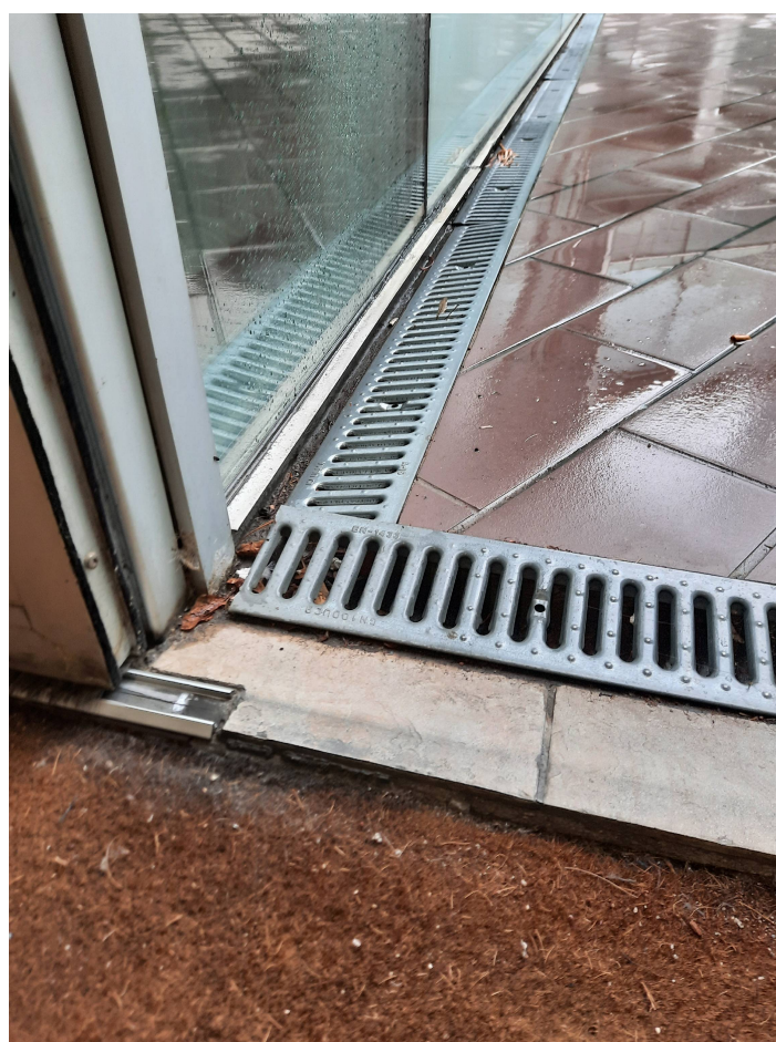
DEFICIENTE ESTADO DE LA REJILLA EN LA ENTRADA A LA DGSIS
