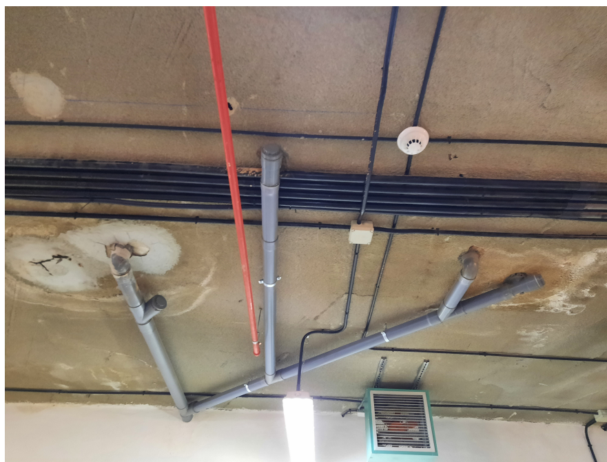
SÓTANO: HUMEDADES EN TECHO Y RED DE COLECTORES COMPLICADA
