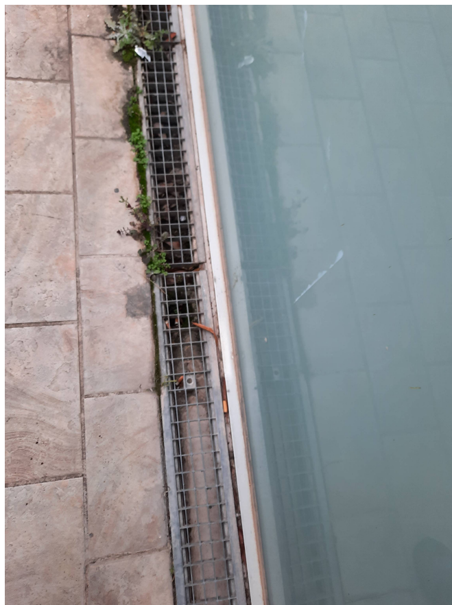
PRESENCIA DE VEGETACIÓN A LO LARGO DE LA CANALETA PERIMETRAL
