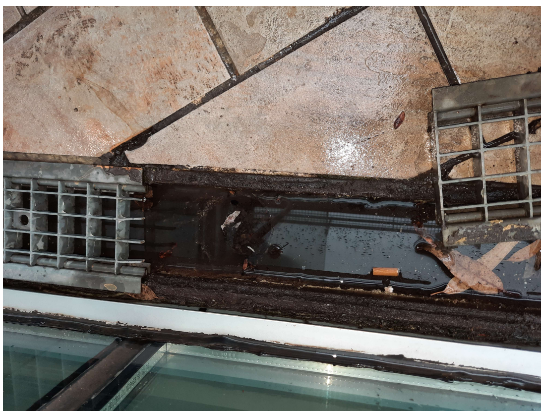
AGUA PLUVIAL RETENIDA EN LA CANALETA PERIMETRAL DEL PATIO
