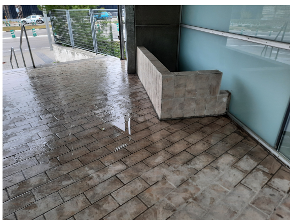
HUMEDADES BAJO LA REJILLA DE VENTILACIÓN DEL ALMACÉN
