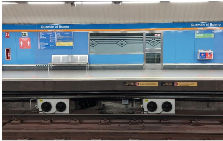
Fig. 7 Figura 2: Unidades exteriores (condensadoras remotas) de los equipos de refrigeración de precisión, de expansión directa, partidos, 1x1, del cuarto de enclavamiento "CE1" de la estación de Guzmán el Bueno.
