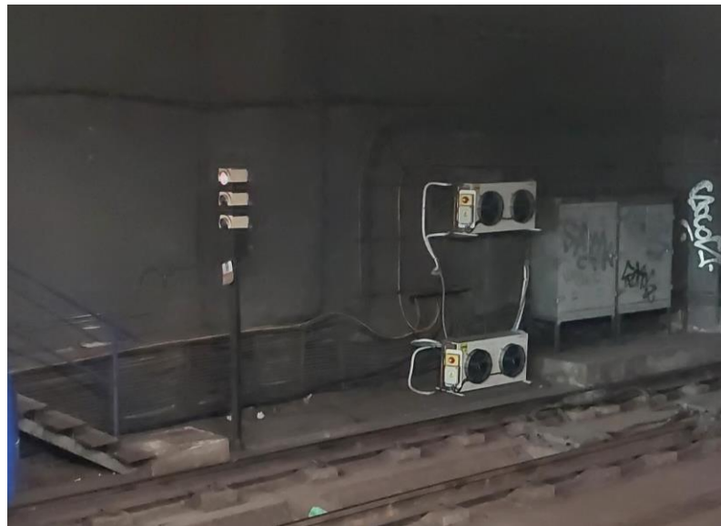
Fig. 6 Figura 1: Unidades exteriores (condensadoras remotas) de los equipos de refrigeración de precisión, de expansión directa, partidos, 1x1, del cuarto de enclavamiento “CE2” de la estación de Gregorio Marañón.
