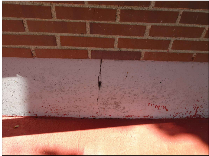
Detalle reparación de fisuras fábrica
