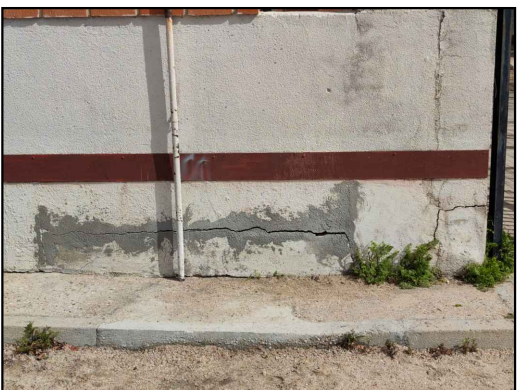
12-13 SE DEMOLERÁ EL CERRAMIENTO DE LA CÁMARA SANITARIA Y SE EJECUTARÁ NUEVO CERRAMIENTO SOBRE NUEVA VIGA DE CIMENTACIÓN CORRIDA. - SE ELIMINARÁ POR COMPLETO EL ENFOSCADO QUE CUBRE LA PIEZA PREFABRICADA ADOSADA AL PILAR 13 Y SE REpondrá INTEGRAMENTE.
