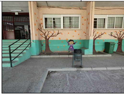
4-5 SE DEMOLERÁ EL CERRAMIENTO DE LA CÁMARA SANITARIA Y SE EJECUTARÁ NUEVO CERRAMIENTO SOBRE NUEVA VIGA DE CIMENTACIÓN CORRIDA. INCLUIRÁ REJILLA DE VENTILACIÓN DE LA CÁMARA SANITARIA. - SE SANEARÁ, PICARÁ Y LIMPIARÁ EL ENFOSCADO Y ACABADO DE PILARES EN TORNO A LAS GRIETAS Y FISURAS Y SE REPARARÁN MEDIANTE VENDA, ENFOSCADO CON INYECCIÓN DE MORTEROS EXPANSIVO Y RESINAS EPOXI.
