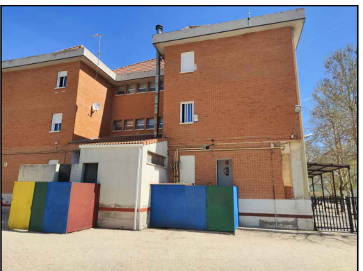
12-13 SE SANEARÁ TODO EL ENFOSCADO DEL ZÓCALO Y SE PINTARÁ.
