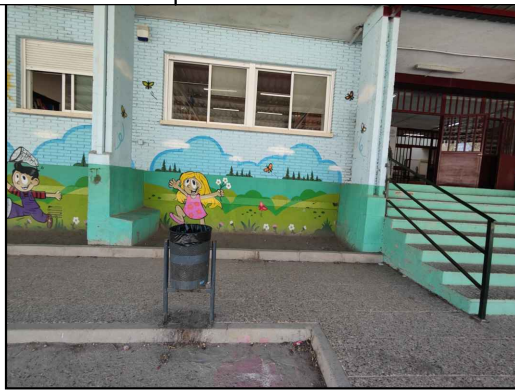
4-5 SE DEMOLERÁ EL CERRAMIENTO DE LA CÁMARA SANITARIA Y SE EJECUTARÁ NUEVO CERRAMIENTO SOBRE NUEVA VIGA DE CIMENTACIÓN CORRIDA. INCLUIRÁ REJILLA DE VENTILACIÓN DE LA CÁMARA SANITARIA. - SE SANEARÁ, PICARÁ Y LIMPIARÁ EL ENFOSCADO Y ACABADO DE PILARES EN TORNO A LAS GRIETAS Y FISURAS Y SE REPARARÁN MEDIANTE VENDA, ENFOSCADO CON INYECCIÓN DE MORTEROS EXPANSIVO Y RESINAS EPOXI.
