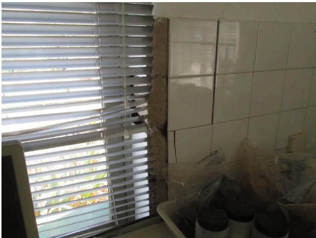
Fotografía n° 20: fisura vertical y caída de azulejos en la hoja interior del cerramiento, junto a una jamba.
