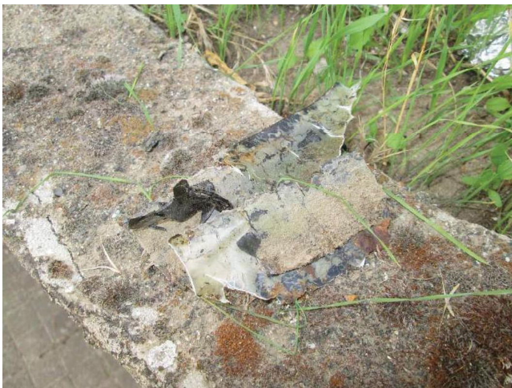
Fotografía n° 24: fragmento del sistema de impermeabilización de las jardineras, desprendido con la mano.
