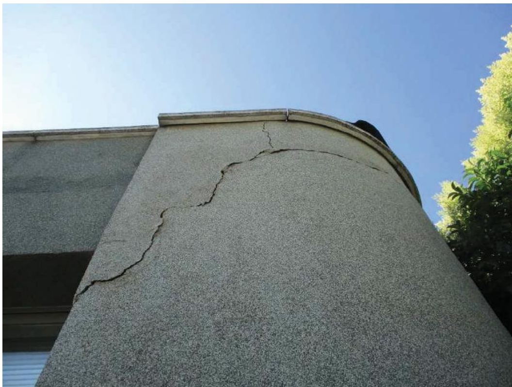
Fotografía nº 12: fisura inclinada y ascendente.
