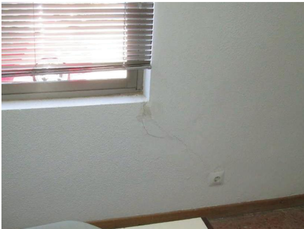
Fotografía n° 16: fisura inclinada en la hoja interior del cerramiento de fachada, con signos de reparación previa.
