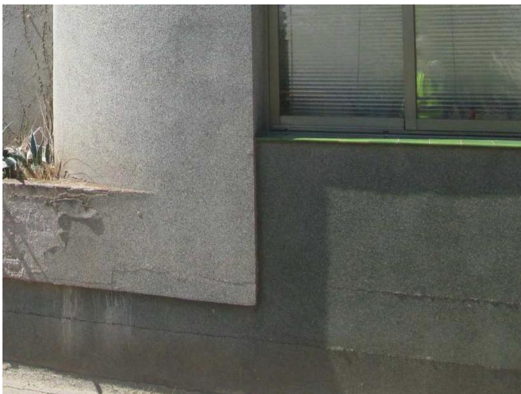
Fotografía nº 2: fisuras horizontales en la parte inferior del cerramiento.
