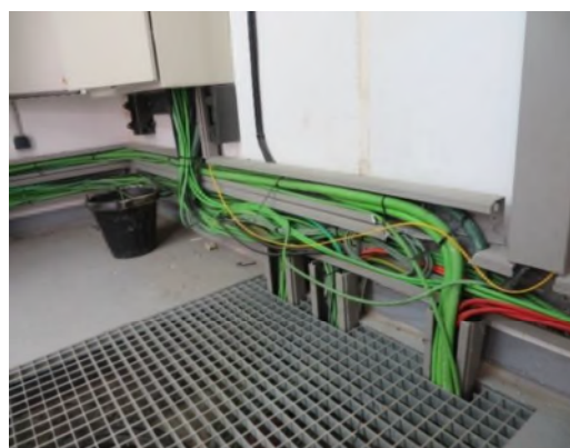
Ilustración 9 y 10. Vista Interior del RTU 2 del tramo 2 / Vista bandeja Industrial Perforada (RTU 3 del tramo 2)
