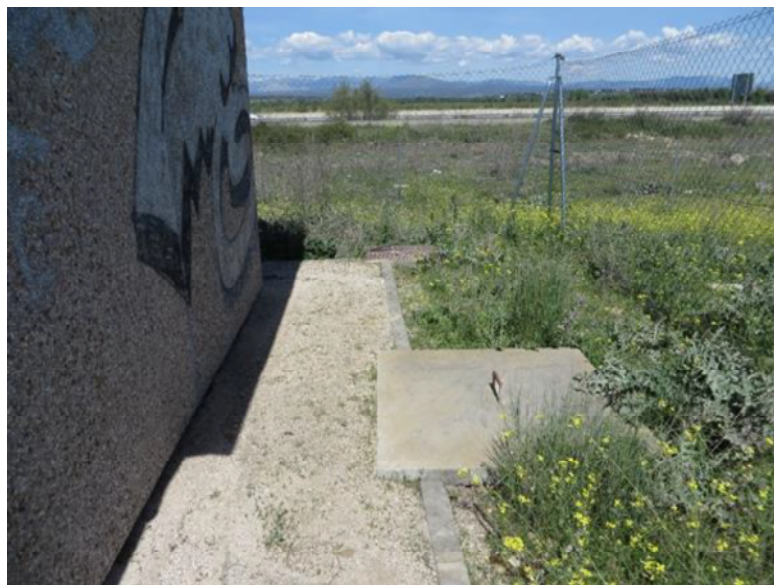
Ilustración 3. Vista de la arqueta exterior de entrada de cables a la Estación de Telecontrol RTU 2 del tramo 1.
